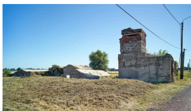
Vue antérieure des casemates a à f, vers le nord-est. Phot. Pierre Thibaut IVR32_20185900554NUCA
