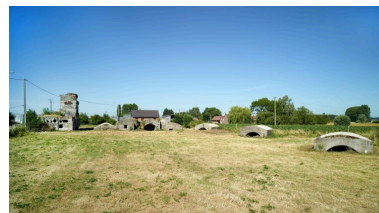
Depuis la casemate j, vue générale vers l'ouest. Phot. Pierre Thibaut IVR32_20185900556NUCA
