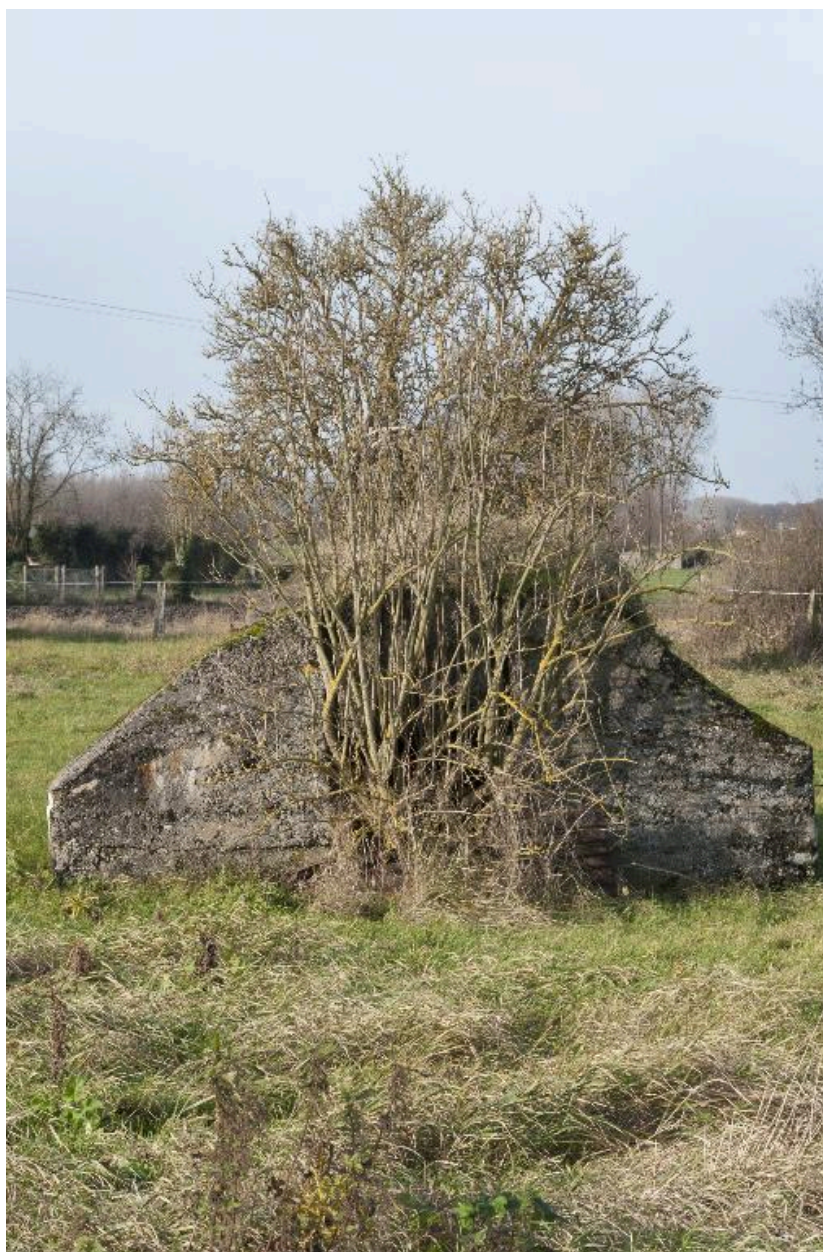
Casemate j, vers le nord-ouest
