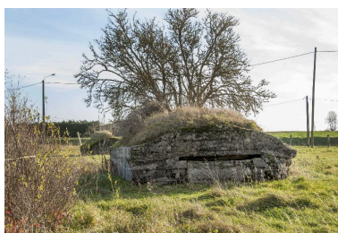
Casemate h (premier plan) et j, vers le sud-est Phot. Jean-Marc Ramette IVR31_20145904935NUCA
