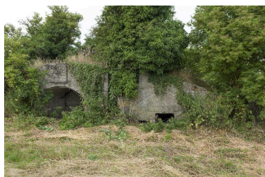
Casemates d et e, vers l'ouest Phot. Jean-Marc Ramette IVR31_20145905248NUCA
