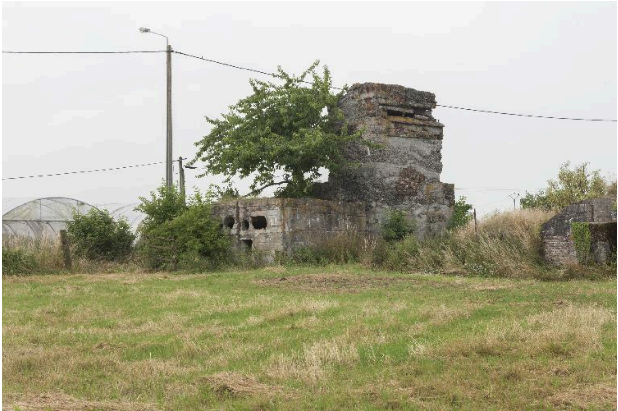
Tour d'observation casematée a, vers le sud-ouest
