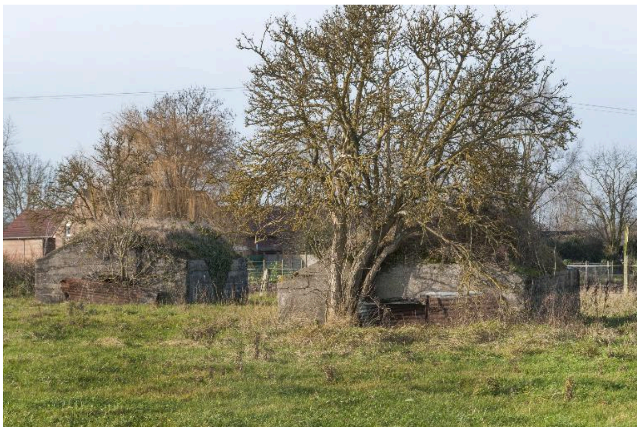
De gauche à droite : Pignons sud des casemates g et h.
