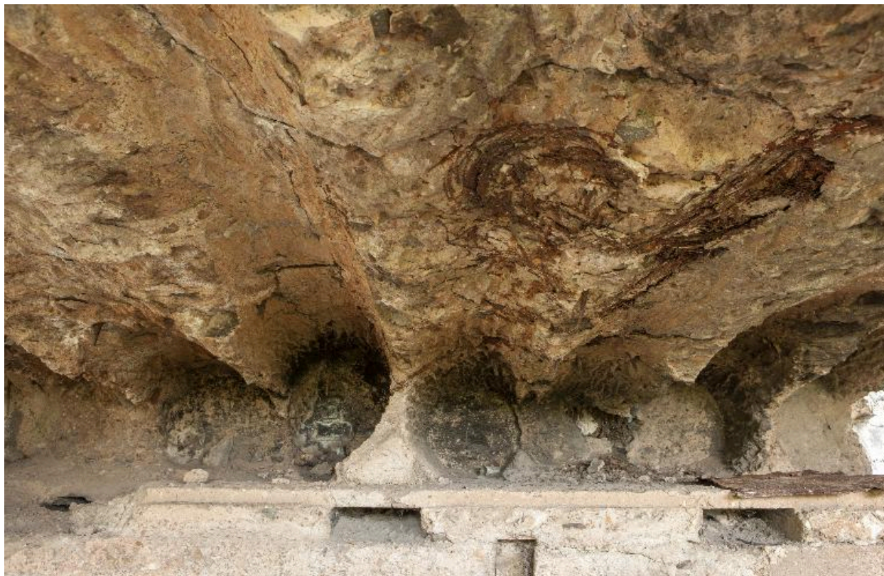
Casemate a, détail du plafond de la salle est. Empreintes des grumes utilisées lors de la construction
