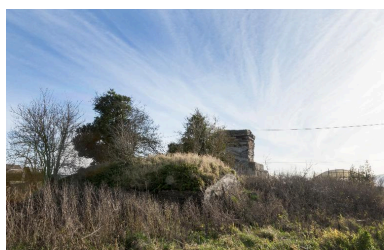
Vue vers le sud-est. Au premier plan l'avers de la casemate c. Phot. Jean-Marc Ramette IVR31_20145904947NUCA
