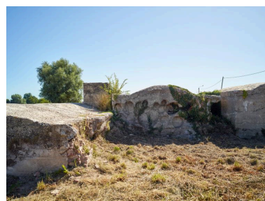
Traces de billes de bois sur la partie postérieure de la casemate d Phot. Pierre Thibaut IVR32_20185900551NUCA
