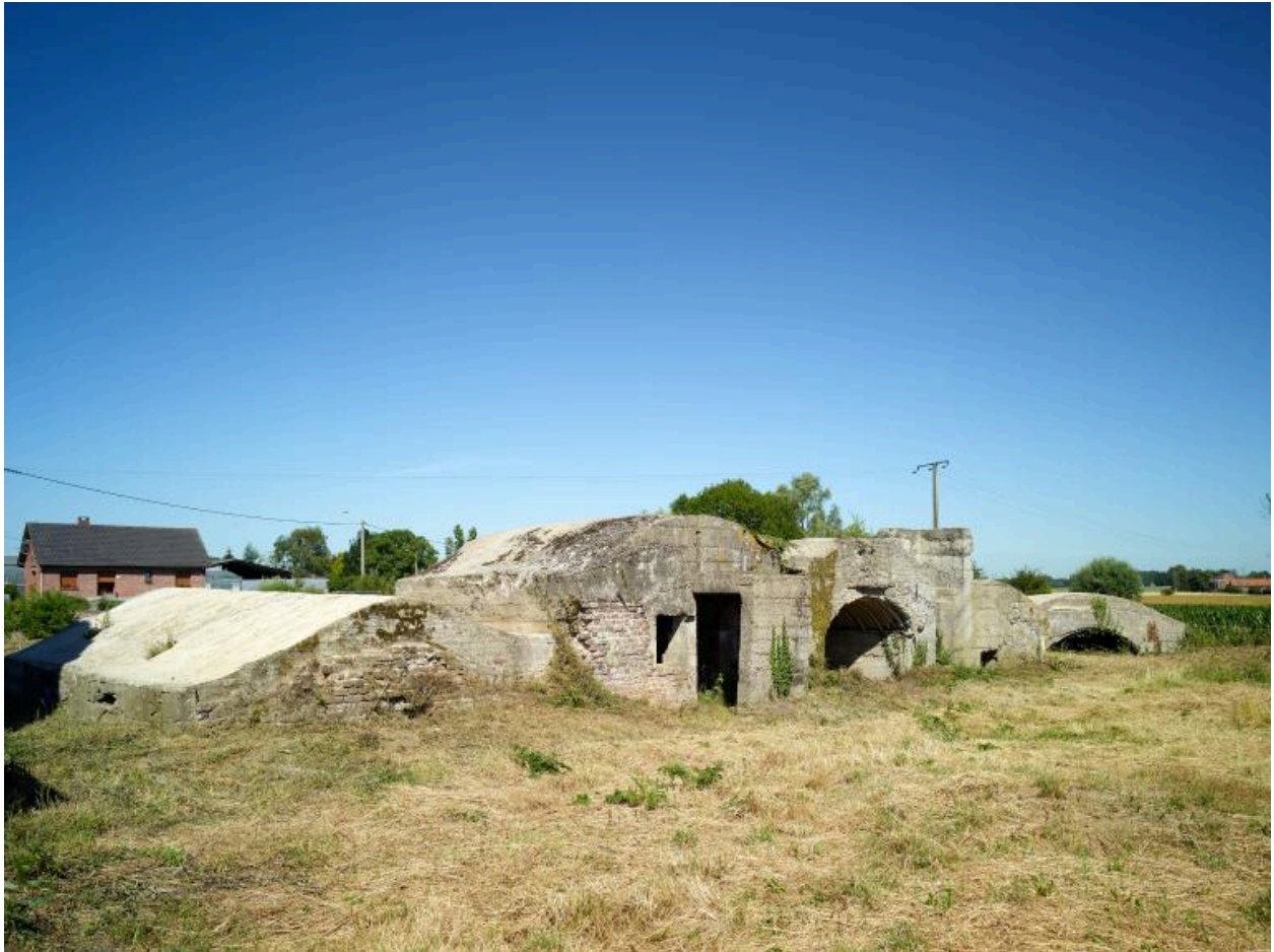
Vue extérieure des casemates b à f, vers le nord-ouest
