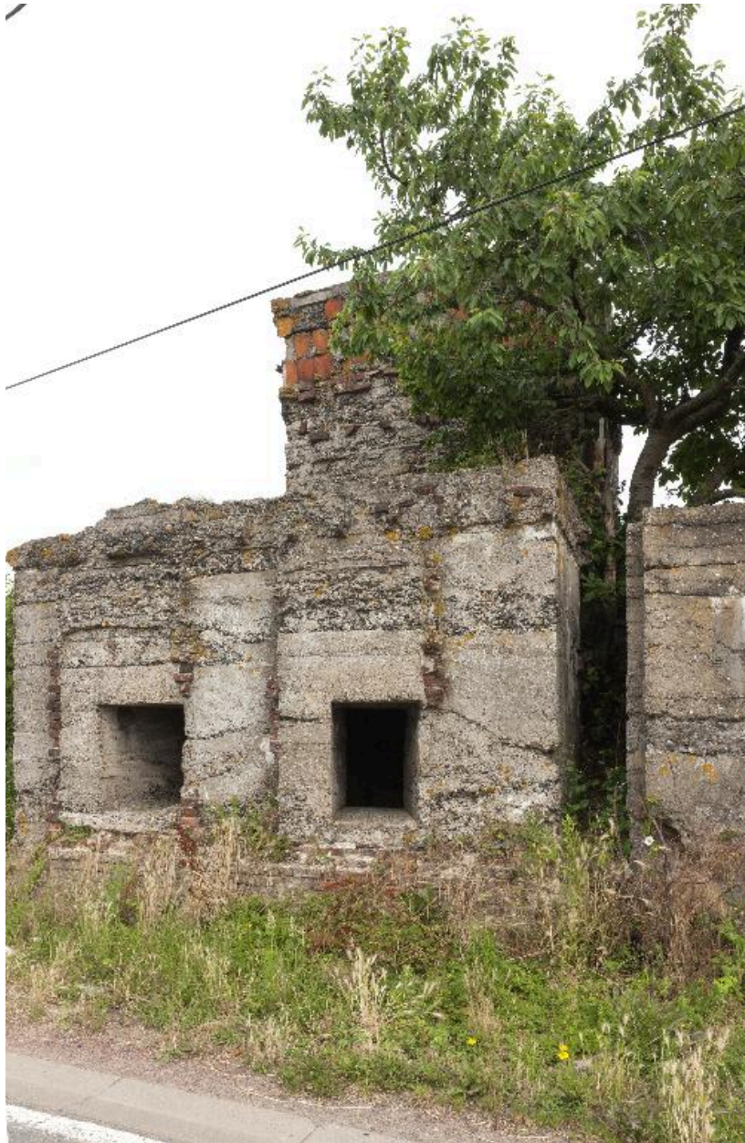
Casemate a, élévation antérieure. Une des ouvertures est biaise.
