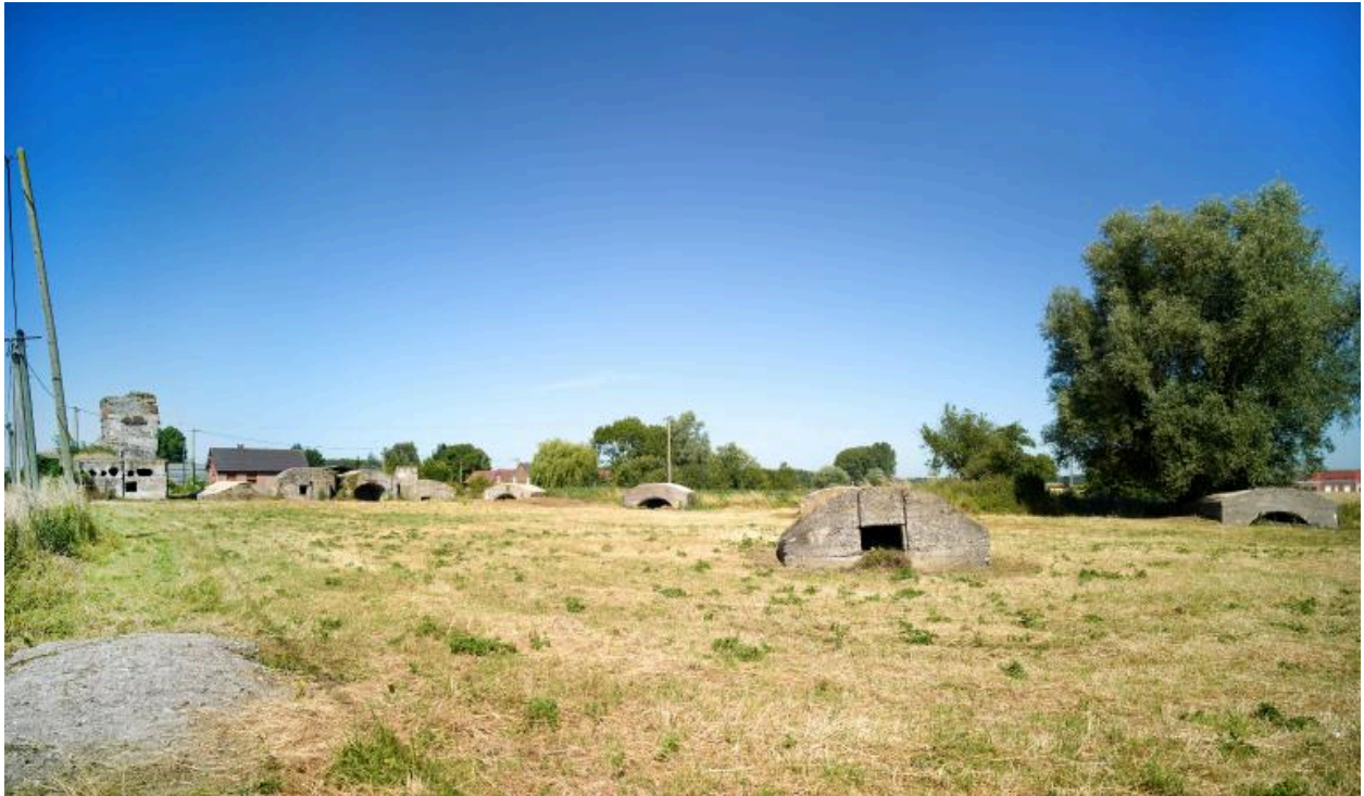
Depuis la casemate k, Vue générale vers l'ouest.
