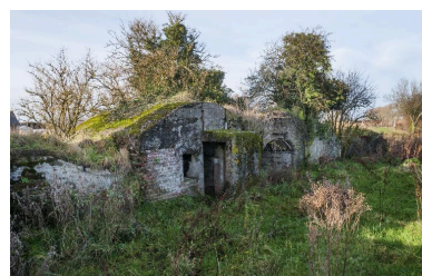
Casemates b, c, d, e et f, en enfilade vers le nord. Phot. Jean-Marc Ramette IVR31_20145905253NUCA
