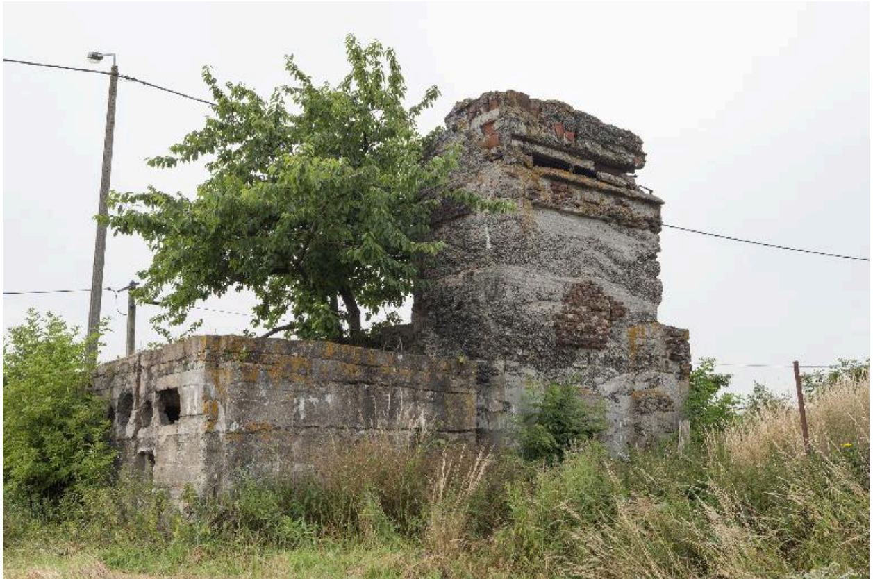
Tour d'observation casematée a, vers le sud-ouest
