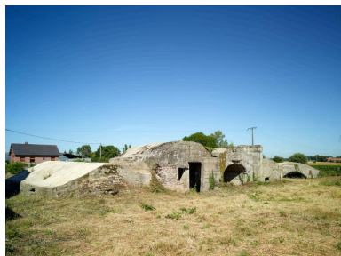
Vue intérieure des casemates b à f, vers le nord-ouest Phot. Pierre Thibaut IVR32_20185900549NUCA
