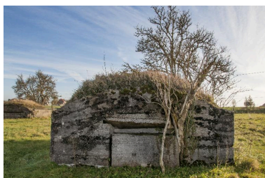
Casemates g, pignon nord. La partie antérieure (vers le front) est équipée d'un bloc de béton amovible doté de deux anneaux... Phot. Jean-Marc Ramette IVR31_20145904930NUCA
