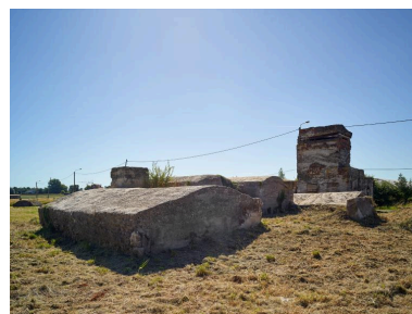
Vue postérieure des casemates a à f (premier plan) vers le sud-est. Phot. Pierre Thibaut IVR32_20185900550NUCA
