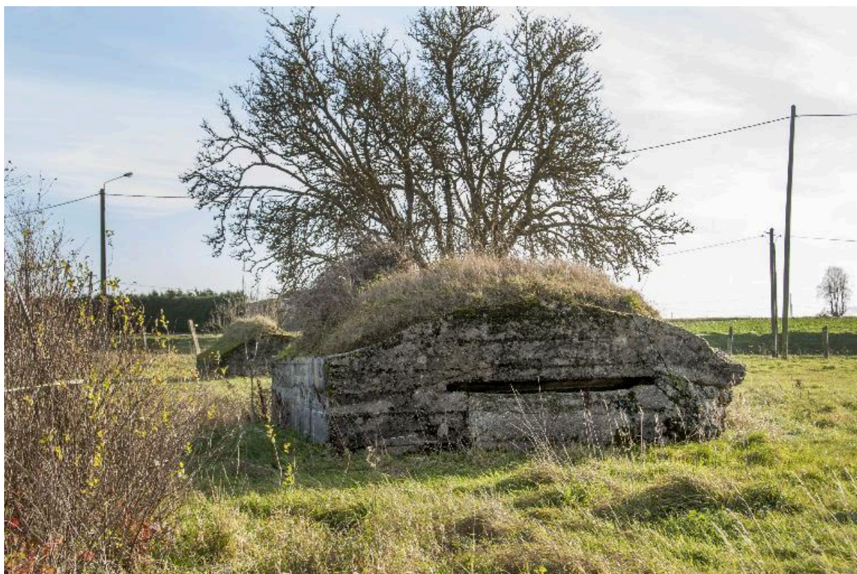
Casemate h (premier plan) et j, vers le sud-est
