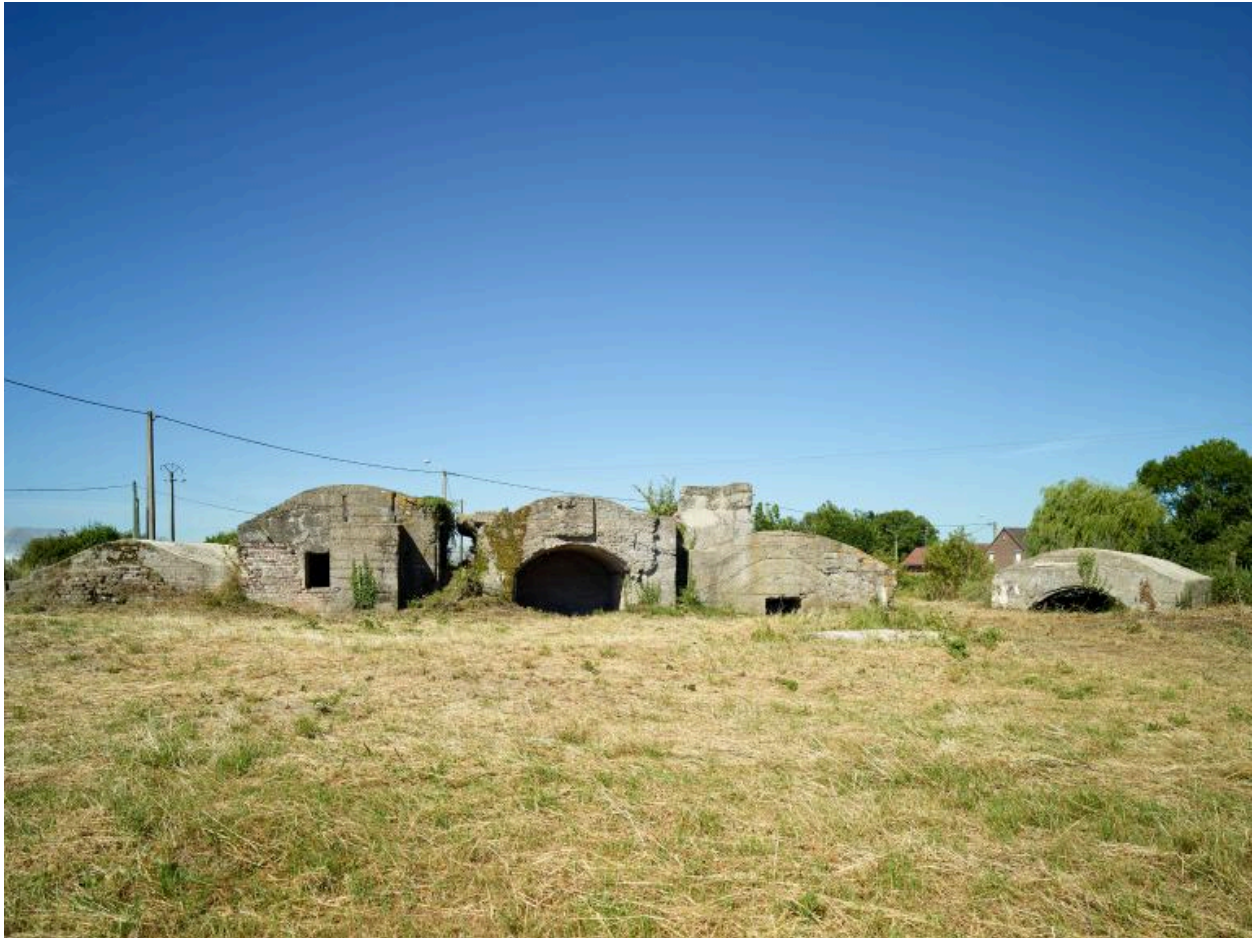
Vue antérieure des casemate a à f, vers l'ouest. On remarque une position de mitrailleuse entre d et e
