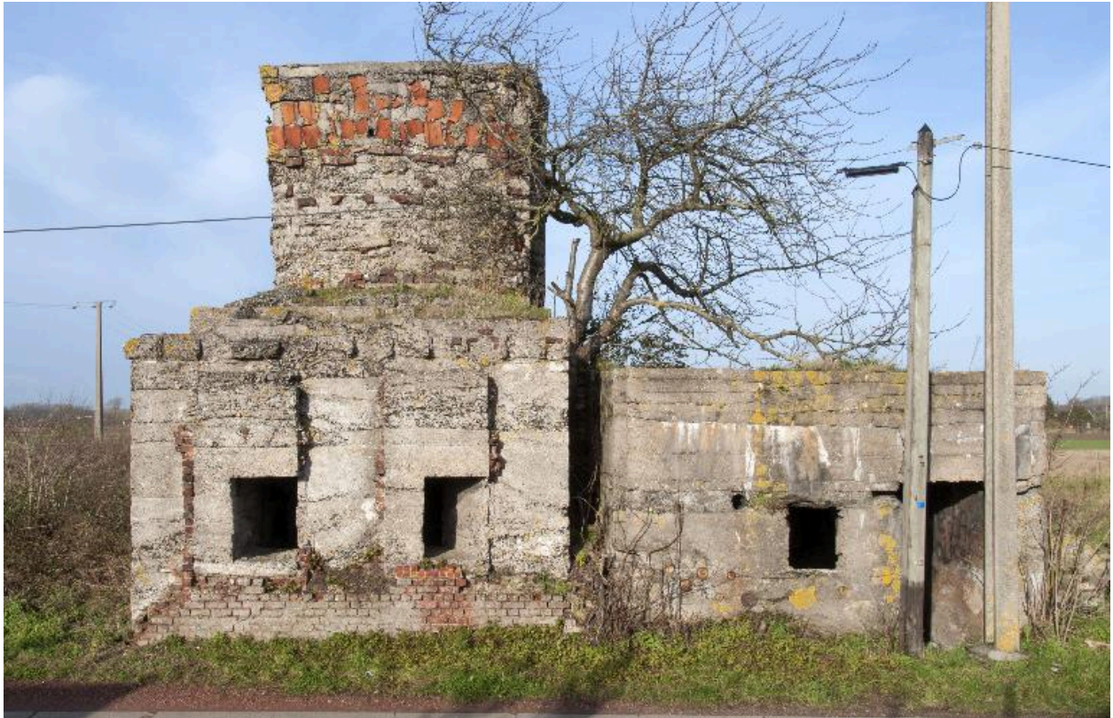
Casemate a. Elévation antérieure sur la rue de Bouchaine, vers le nord
