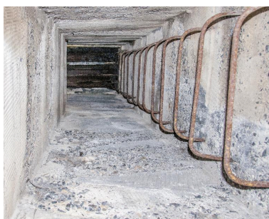
Tour d'observation casematé a. Echelons métalliques menant à la plateforme d'observation Phot. Jean-Marc Ramette IVR31_20145904973NUCA
