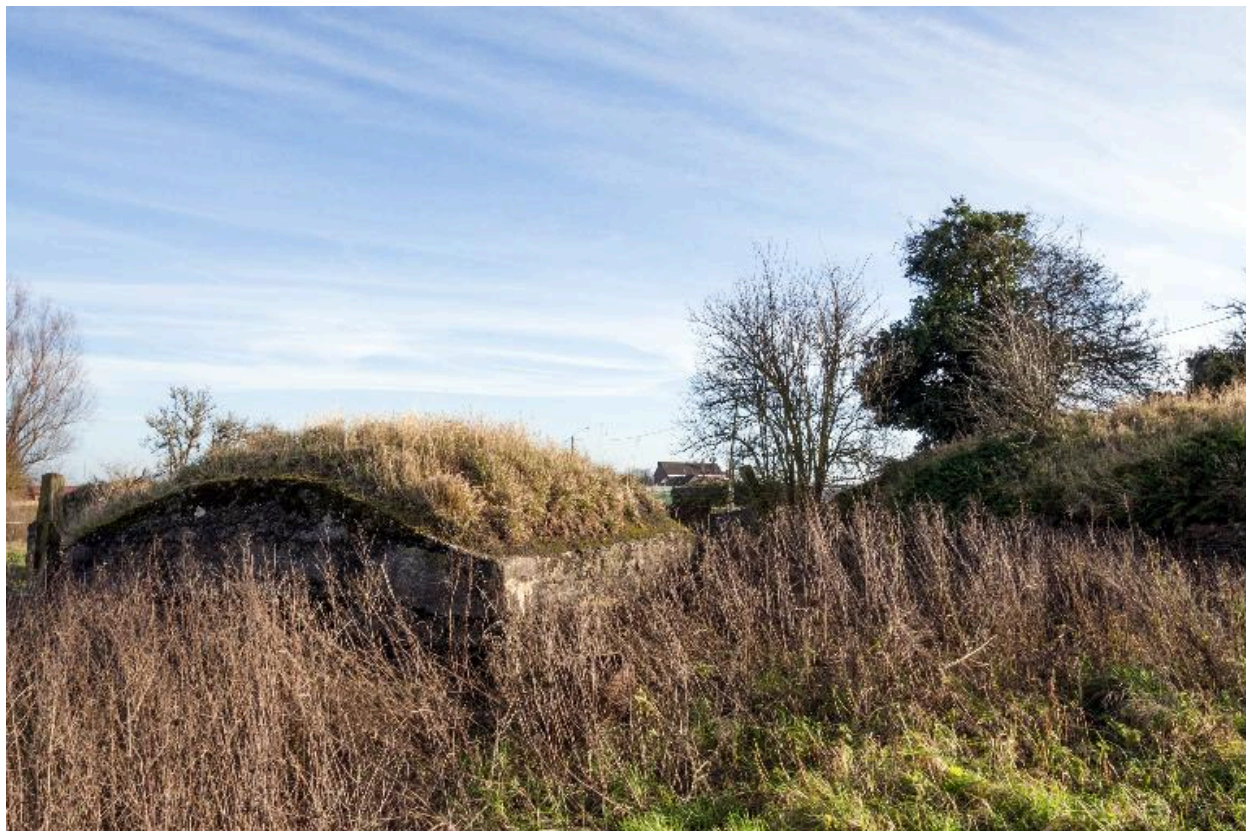
Casemate d, vers sud-est
