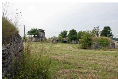
De gauche à droite, bâtiments h, a, b, c, d, e et g, vers le sud-ouest Phot. Jean-Marc Ramette IVR31_20145905254NUCA
