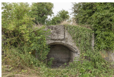
Casemate d, vers l'ouest Phot. Jean-Marc Ramette IVR31_20145905247NUCA
