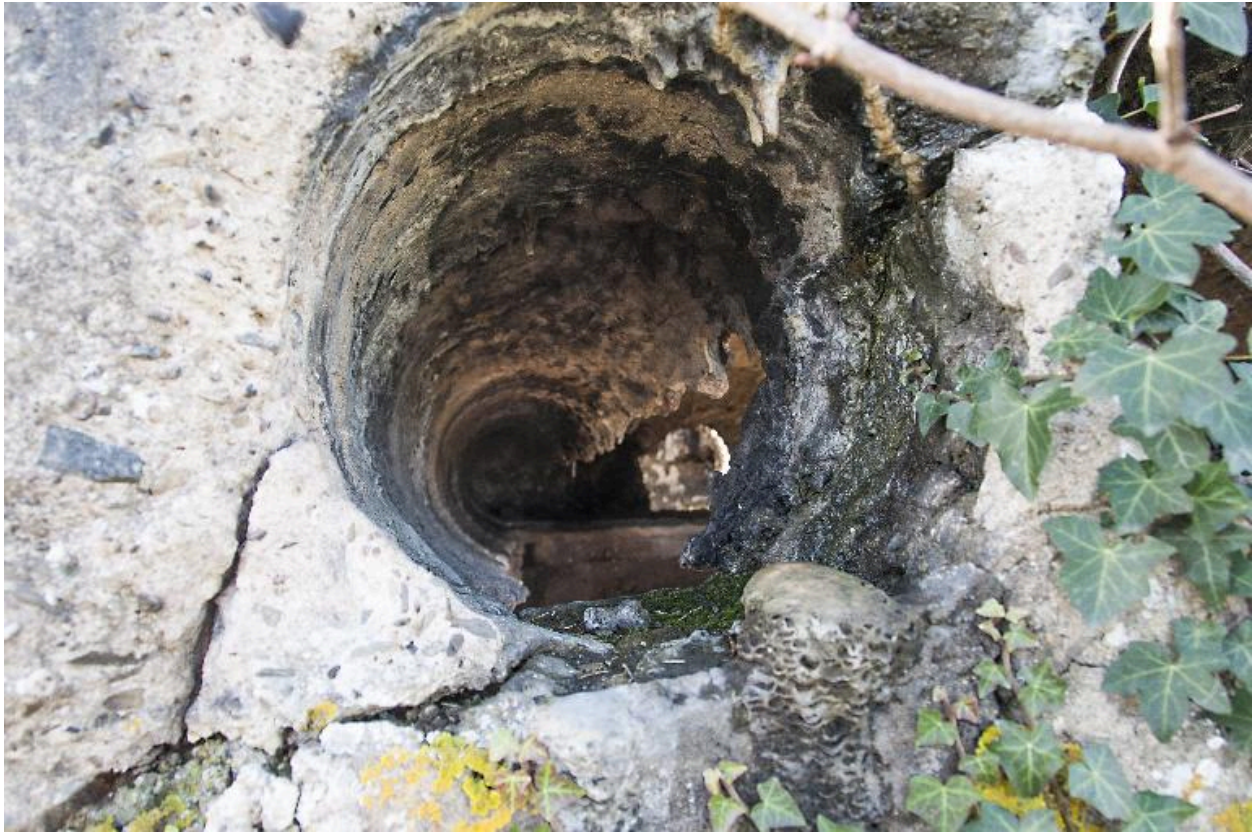
Bâtiment a, salle est. Orifice de sortie d'une grume, aujourd'hui disparue, utilisée lors de la construction
