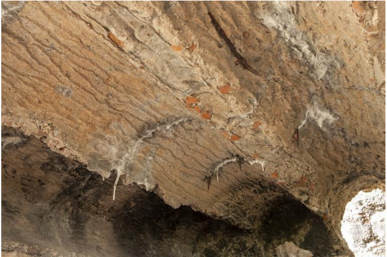
Casemate a, détail du plafond de la salle est. Empreintes des grumes utilisées lors de la construction
