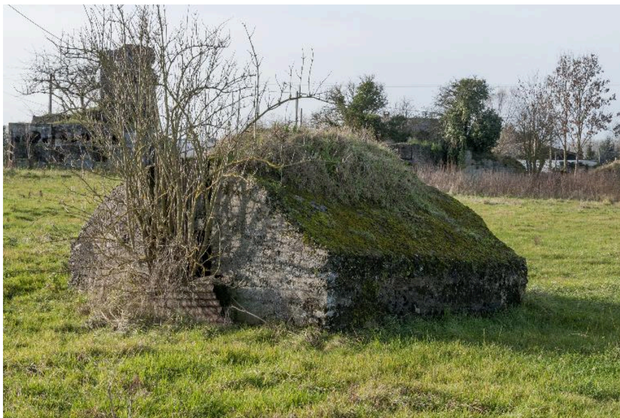
Casemate j, vers le nord-ouest
