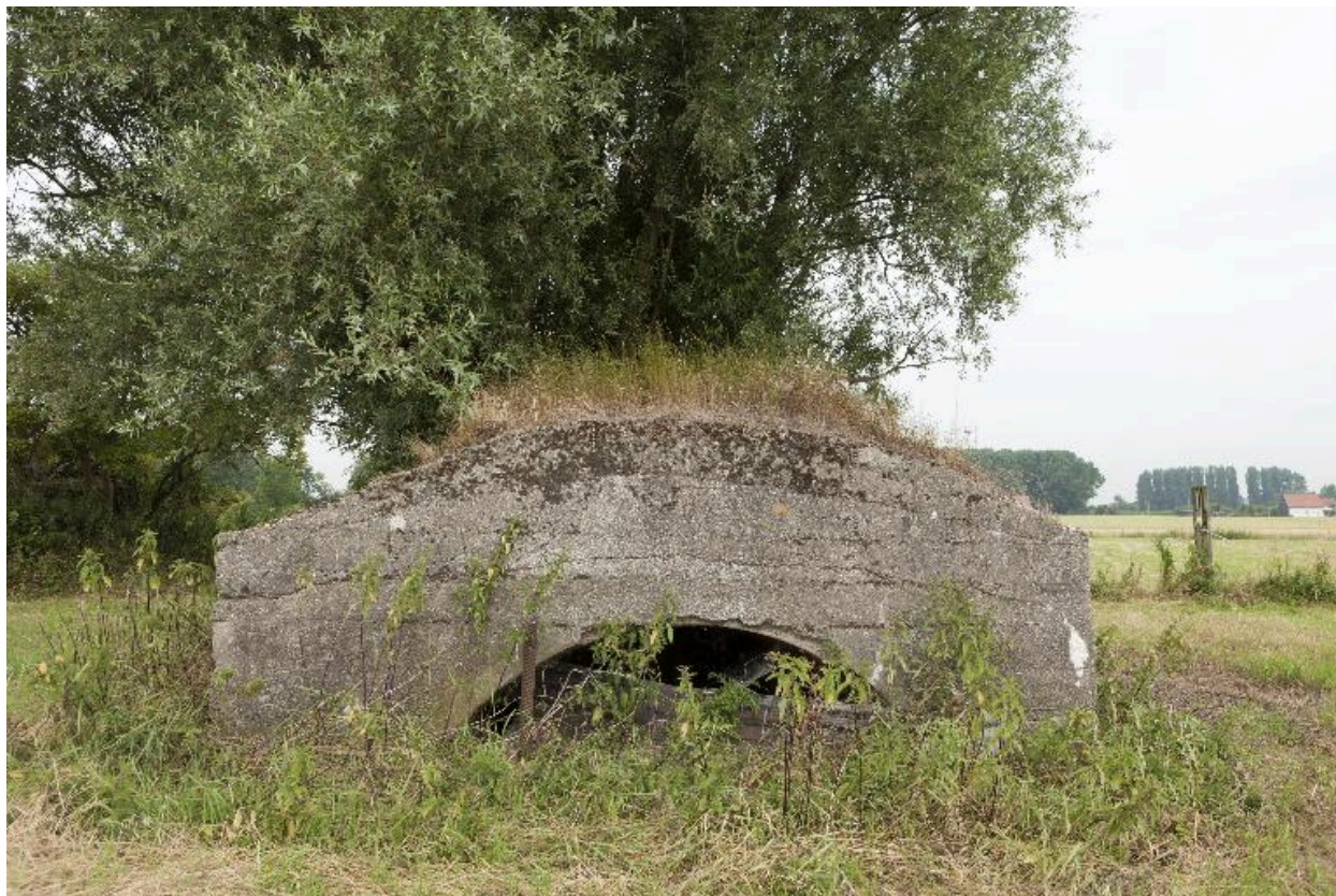
Casemate i, ouverture sud
