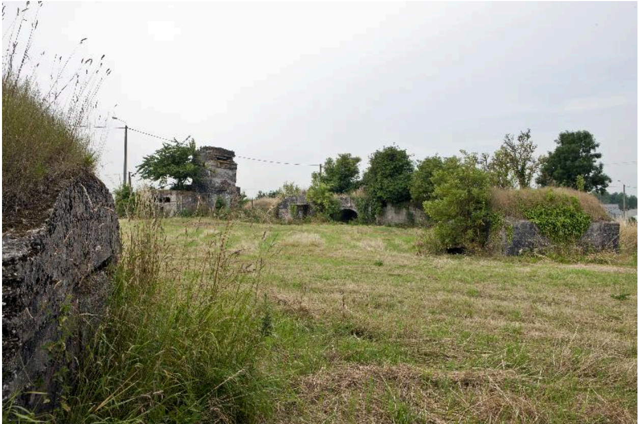
De gauche à droite, bâtiments h, a, b, c, d, e et g, vers le sud-ouest
