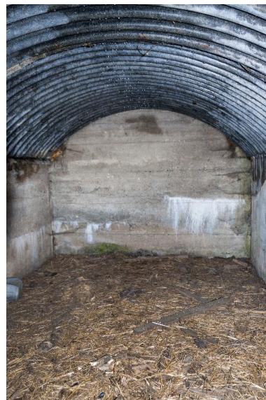
Casemate b. Vue intérieure de la voûte en tôle "métro" Phot. Jean-Marc Ramette IVR31_20145904988NUCA
