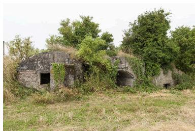
Elévations est des casemates b, c et d. Phot. Jean-Marc Ramette IVR31_20145905251NUCA
