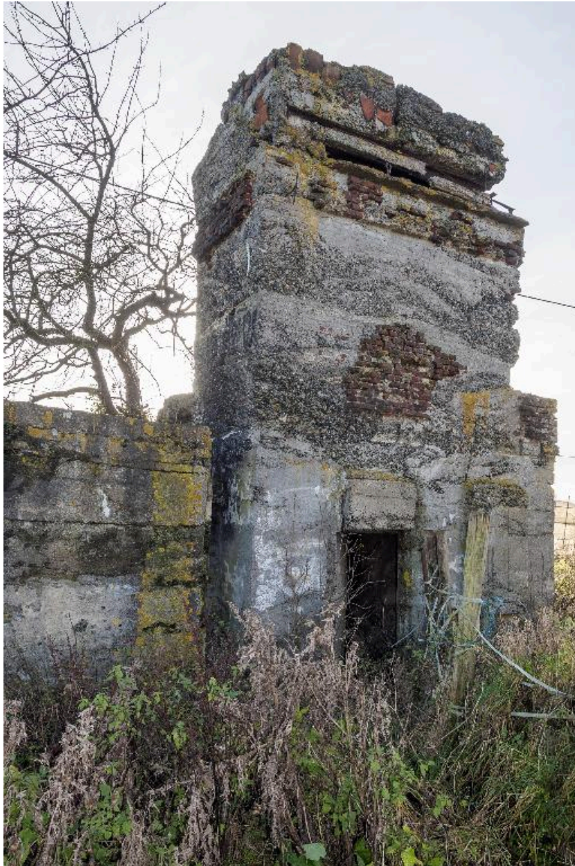
Tour d'observation casematée a, entrée sur l'élévation nord
