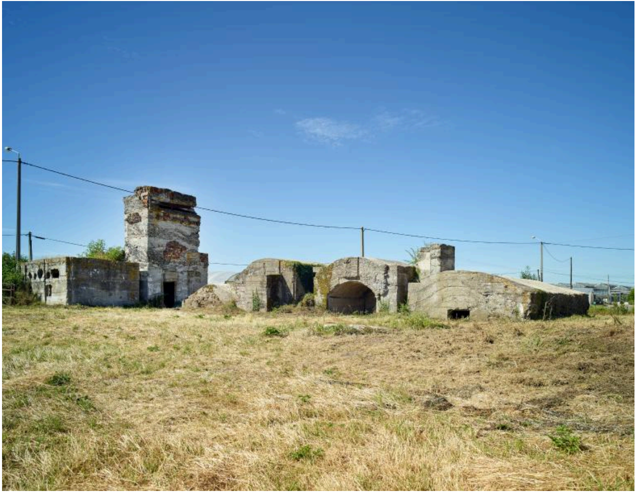
De gauche à droite, les casemates a à e, vers le sud-ouest.
