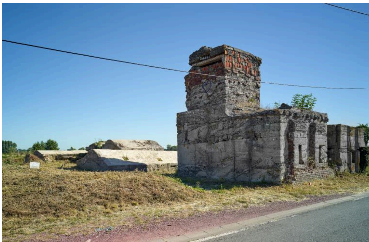
Casemate a, vers le nord-est.
