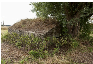
Casemate i, vers le sud-ouest Phot. Jean-Marc Ramette IVR31_20145904940NUCA
