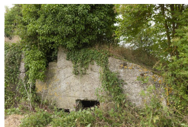
Casemate e, vers l'ouest Phot. Jean-Marc Ramette IVR31_20145904945NUCA
