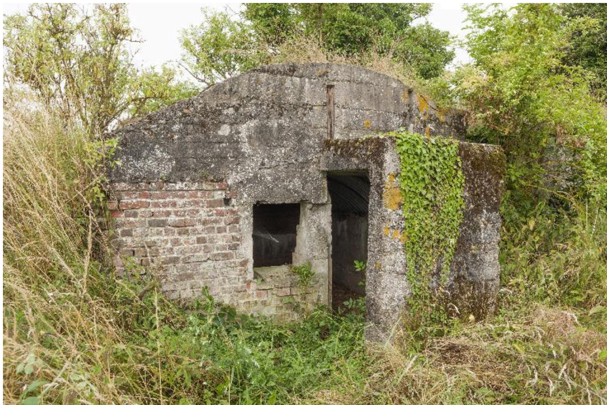
La casemate b et son entrée pare-souffle
