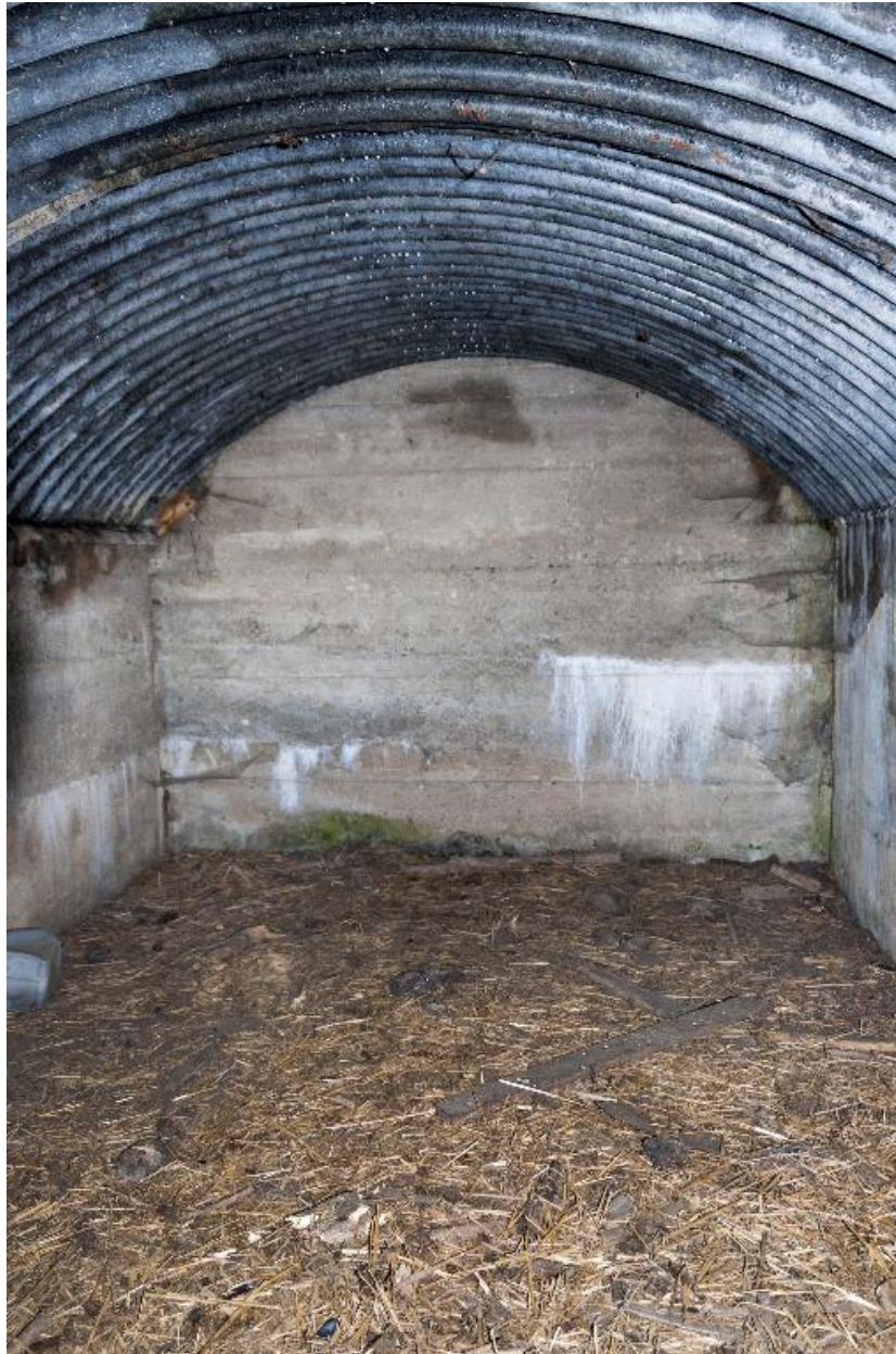
Casmate b. Vue intérieure de la voûte en tôle "métrô"
