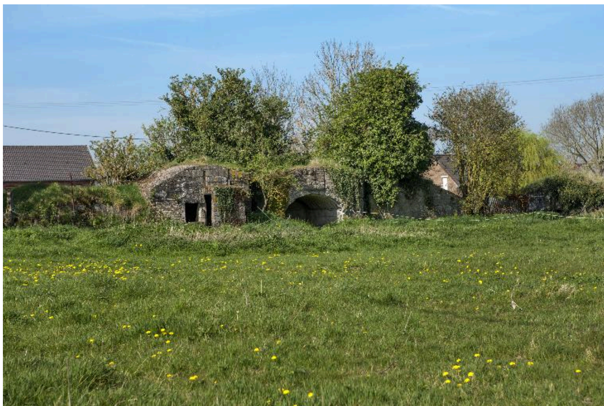
Casemates b, c, d, e, f (sous la végétation)
