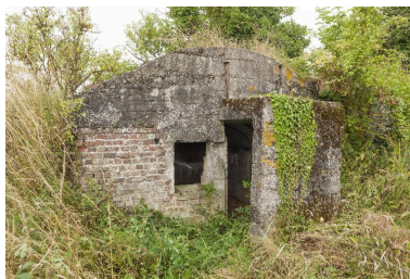
La casemate b et son entrée pare-souffle Phot. Jean-Marc Ramette IVR31_20145905252NUCA
