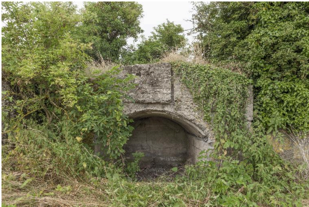
Casemate d, vers l'ouest
