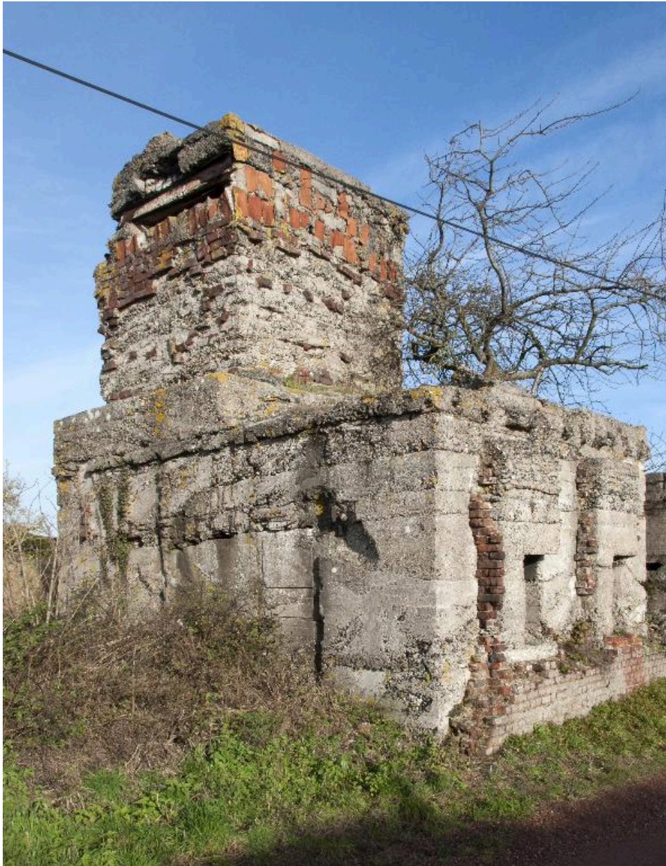
Tour d'observation casematé a, vers nord-est
