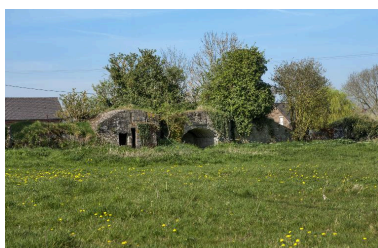
Casemates b, c, d, e, f (sous la végétation) Phot. Jean-Marc Ramette IVR31_20145905250NUCA
