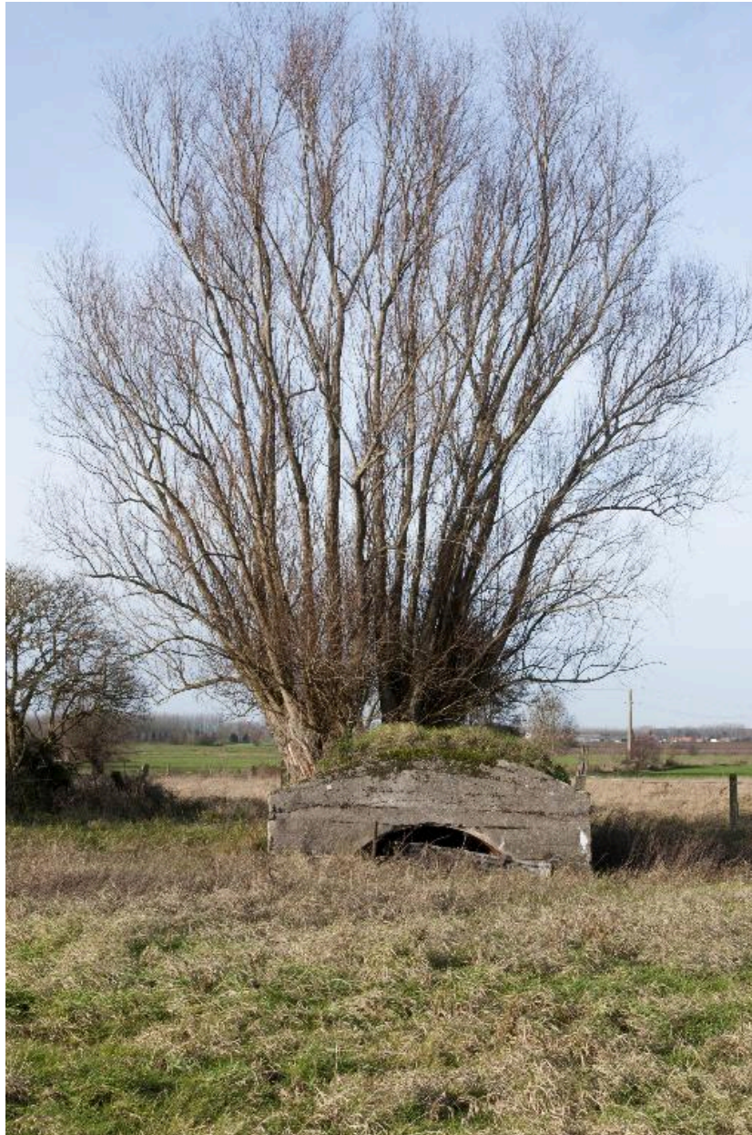
Casemate i, vers le nord-ouest
