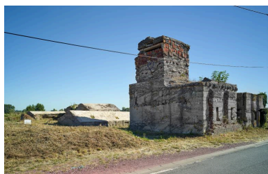
Casemate a, vers le nord-est. Phot. Pierre Thibaut IVR32_20185900555NUCA
