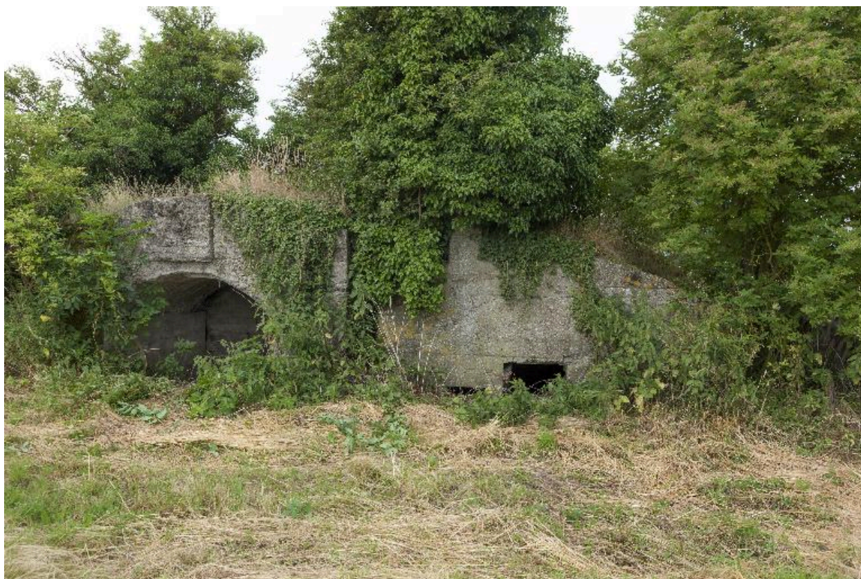
Casemates d et e, vers l'ouest
