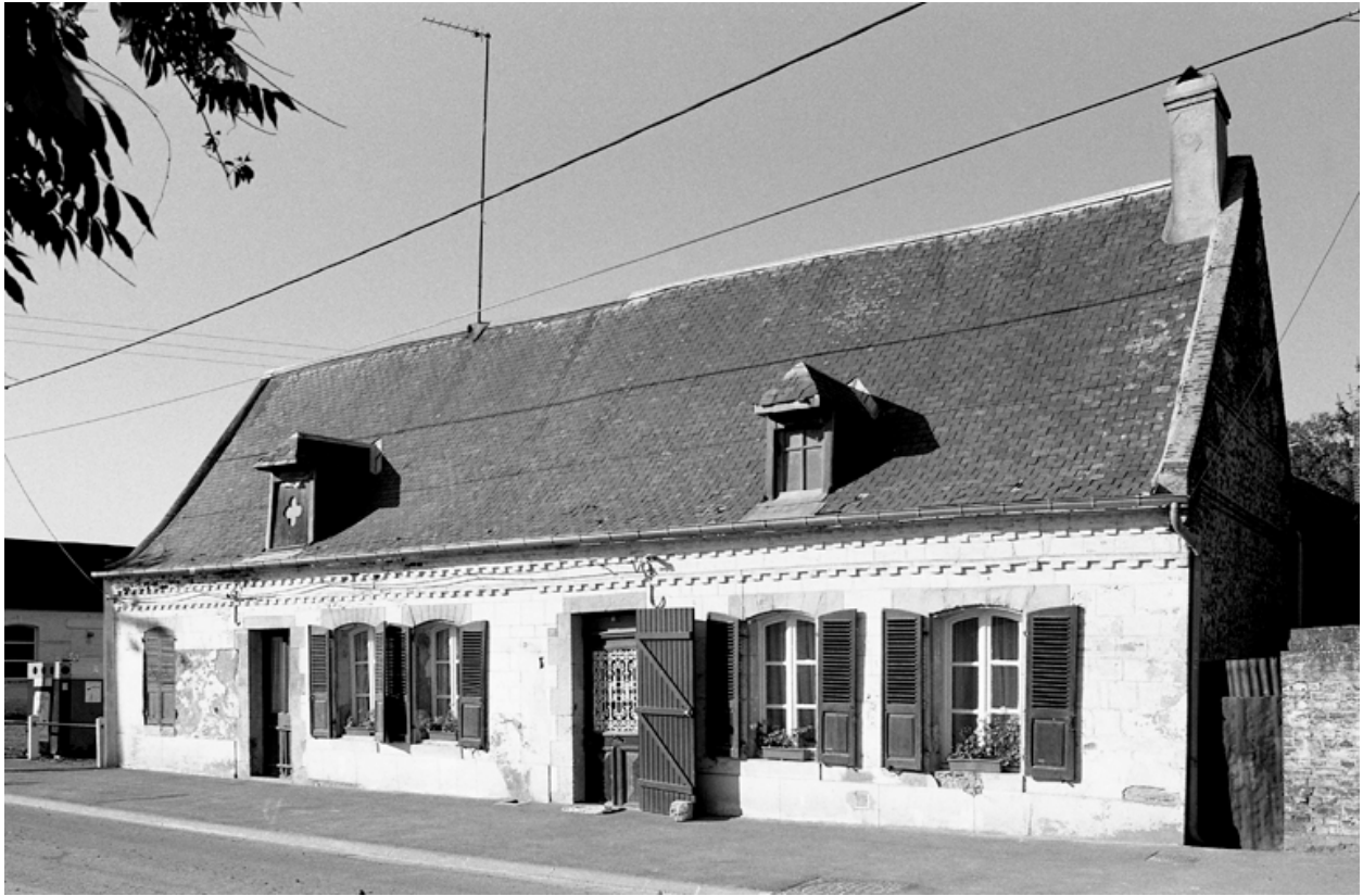
Vue d'ensemble nord-est.
