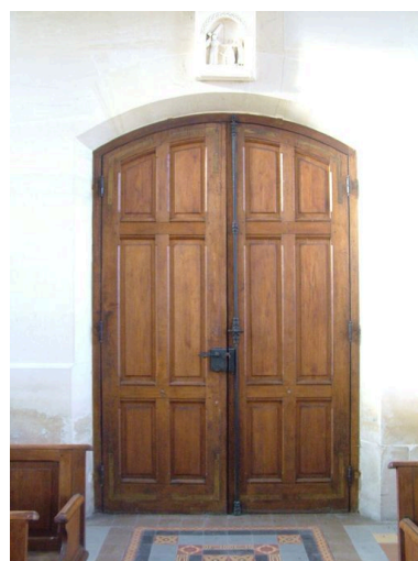
Vue de la porte d'entrée en chêne. Phot. Inès Guérin IVR22_20050200362NUCA
