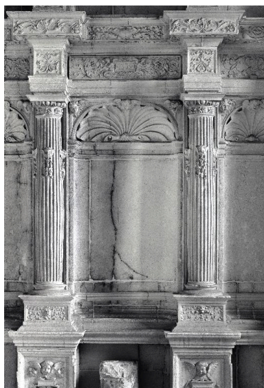
Vue de la niche centrale du niveau inférieur. Phot. Thierry Lefébure IVR22_19900202197X
