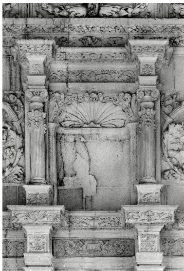
Vue de la niche du niveau supérieur. Phot. Thierry Lefébure IVR22_19900202199X
