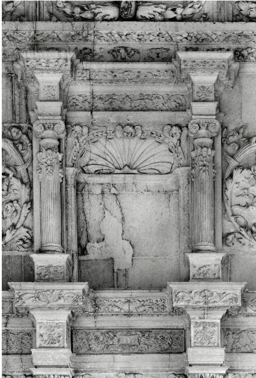
Vue de la niche du niveau supérieur.
