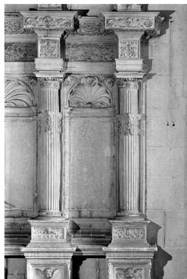
Vue de la niche droite du niveau inférieur. Phot. Thierry Lefébure IVR22_19900202198X
