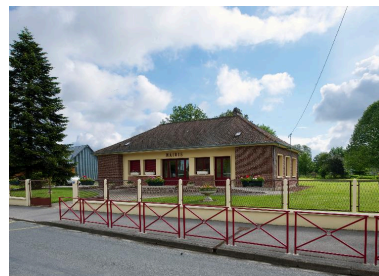
La mairie d'Aigneville. Phot. Thierry Lefébure IVR22_20138000245NUC2A
