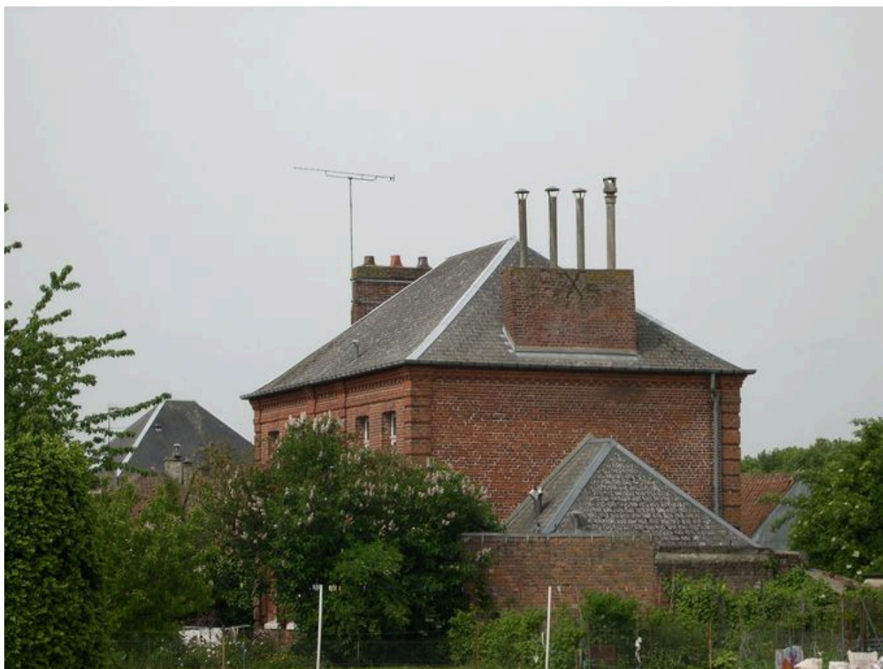
Vue de situation depuis le nord-est.
