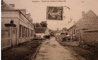
Vue latérale de la construction au début du 20e siècle. Phot. Inès Guérin IVR22_20078005799NUCAB
