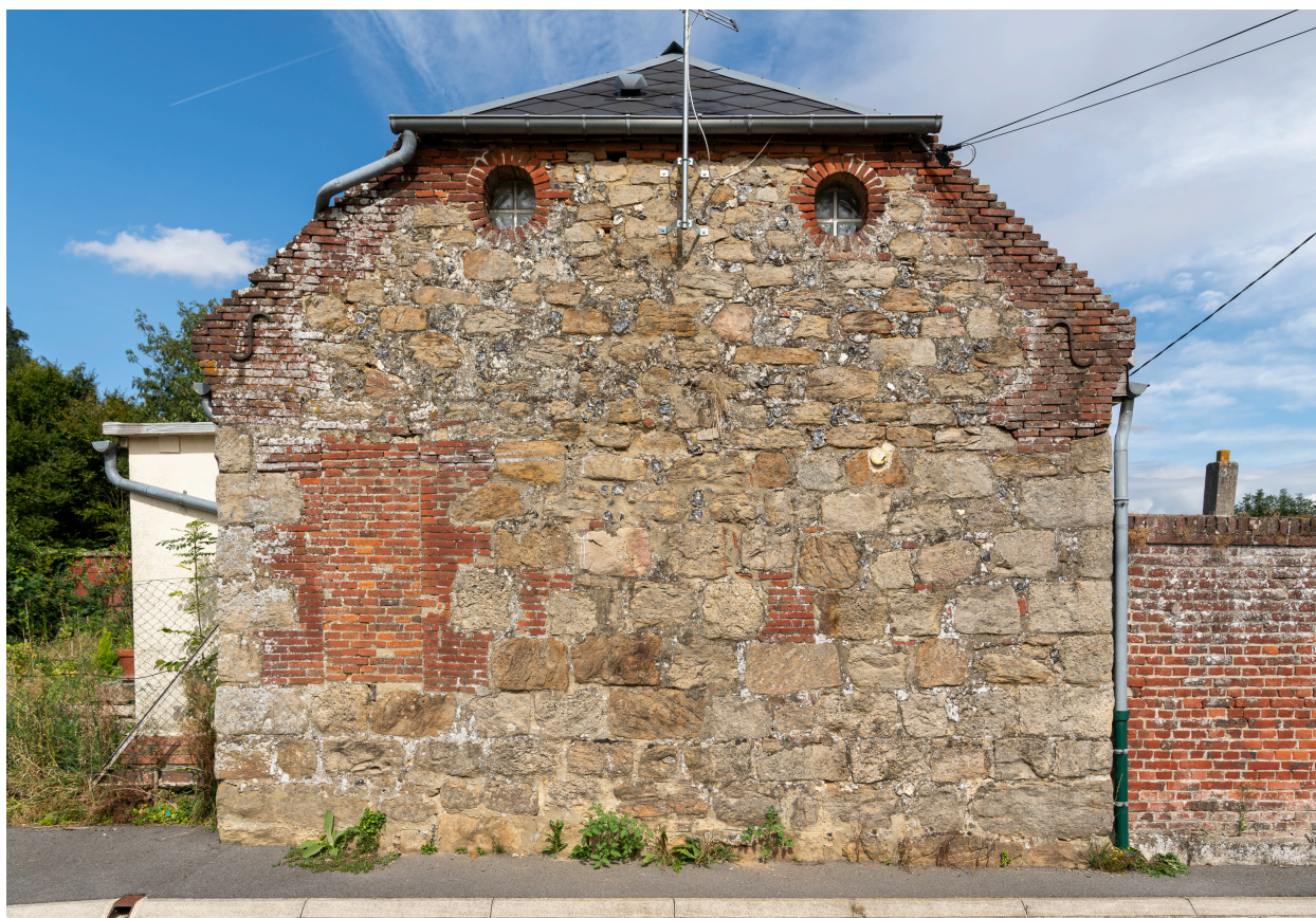
Pignon sur rue en appareil mixte de grès, brique et silex, n°5 de la rue du Puits d'Amour, vue depuis le sud.
