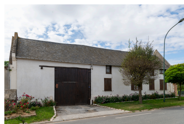
Entrée charretière et logis d'une ferme à cour, n°7 de la rue de la Chaussée Brunehaut, vue depuis l'est. Phot. Marc Kérignard IVR32_20246000868NUCA
