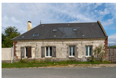
Logis en pierre, n°4 de la Chaussée Brunehaut, vue depuis l'est. Phot. Marc Kérignard IVR32_20246000871NUCA
