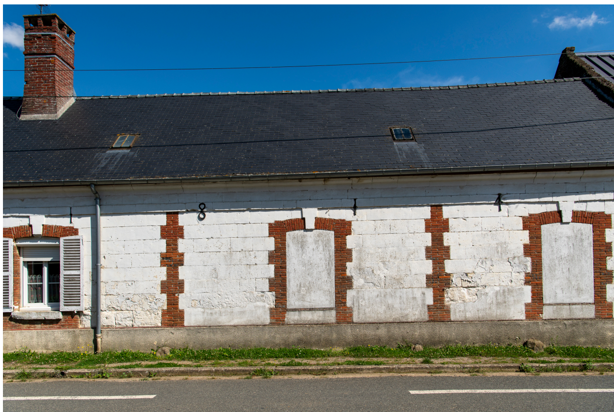
Façade sur rue avec date portée "1814" sur les fers d'ancrages.
