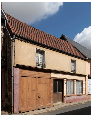
Ancien magasin de commerce, n°6 de la rue de la Halle, vue depuis le sud. Phot. Marc Kérignard
