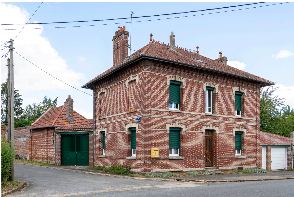
Demeure en brique, n°21 de la rue du Bail, vue depuis le sud.
