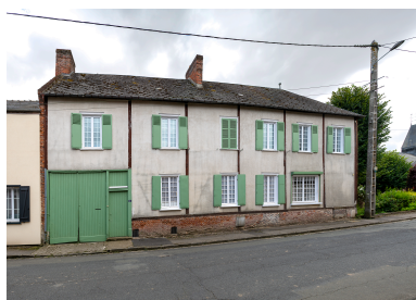
Logis sur rue, n°2 de la rue du Bail, vue depuis le nord. Phot. Marc Kérignard IVR32_20246000831NUCA
