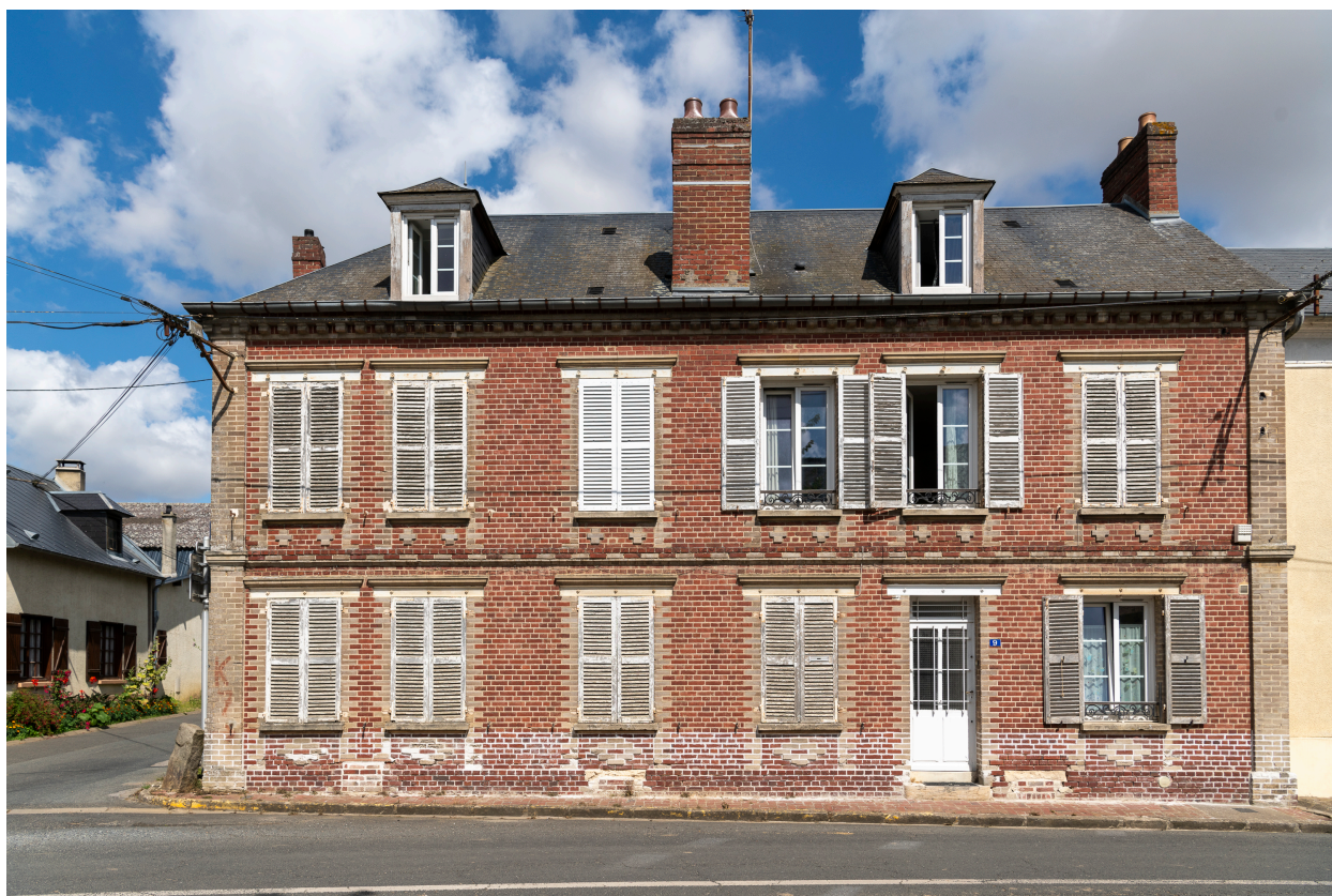
Demeure en brique, n°9 de la rue du Bail, vue depuis le sud.
