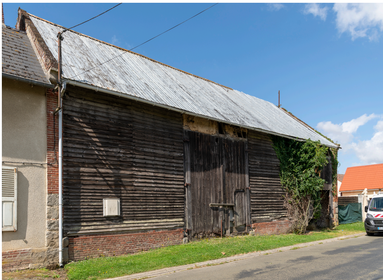
Ancienne grange alignée sur la rue, n°26 de la rue Henri-Sohier, vue depuis l'est.
