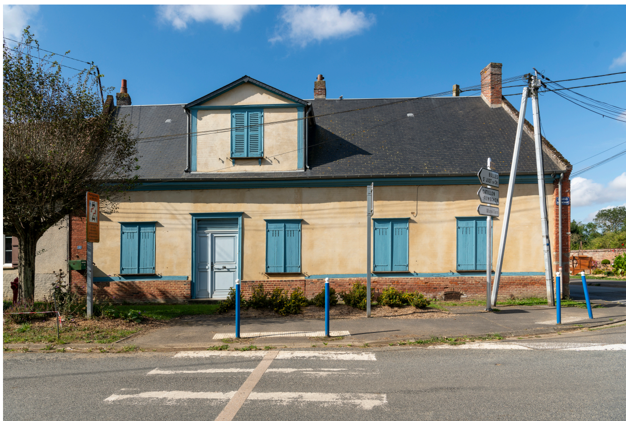
Logis sur rue, n°41 de la Chaussée Brunehaut, vue depuis l'est.
