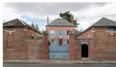
Demeure, n°16 de la rue du Bail, vue depuis le nord. Phot. Marc Kérignard IVR32_20246000830NUCA
