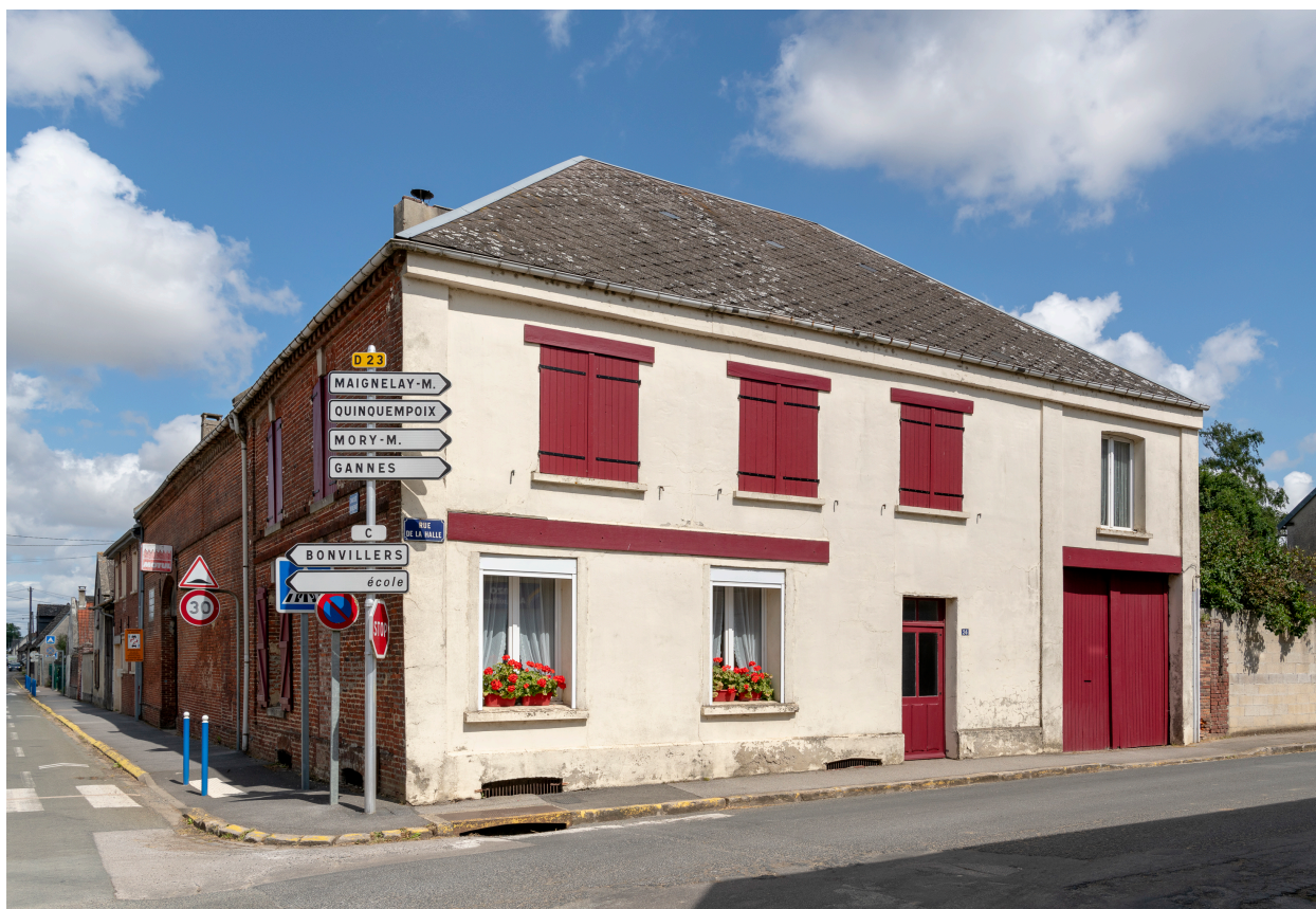
Ancien commerce "La Ruche", n°24 de la rue de la Halle, vue depuis le sud.
