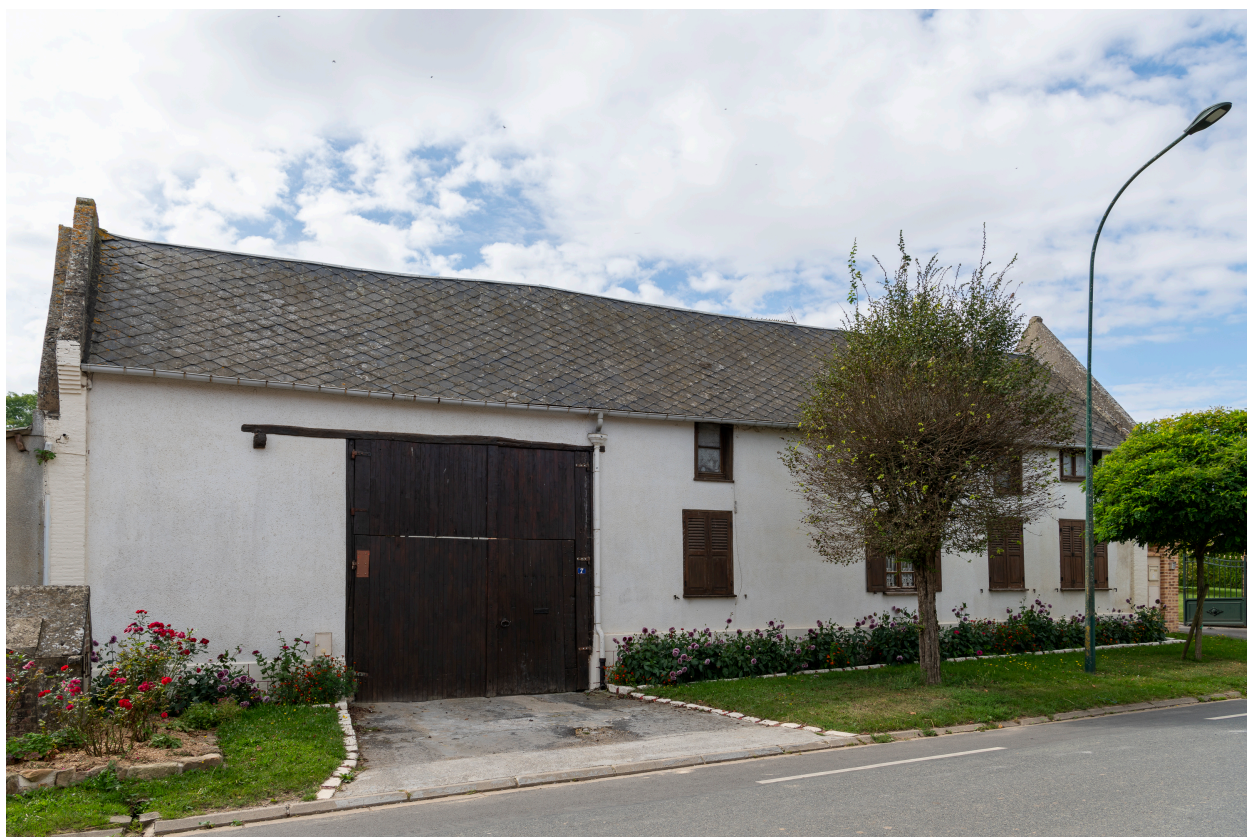
Entrée charretière et logis d'une ferme à cour, n°7 de la rue de la Chaussée Brunehaut, vue depuis l'est.
