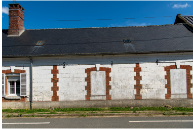
Façade sur rue avec date portée "1814" sur les fers d'ancrages. Phot. Marc Kérignard IVR32_20246000851NUCA
