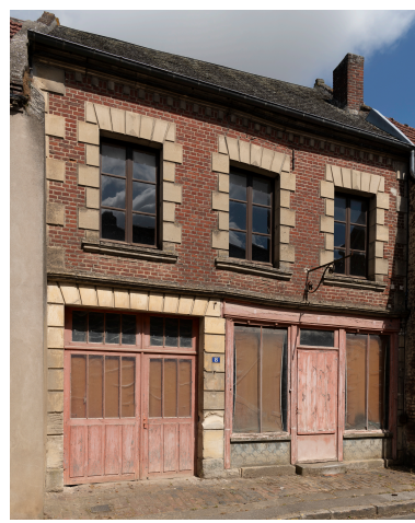
Ancien magasin de commerce, n°8 de la rue de la Halle, vue depuis le sud. Phot. Marc Kérignard
