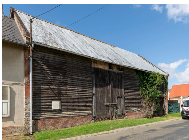
Ancienne grange alignée sur la rue, n°26 de la rue Henri- Sohier, vue depuis l'est. Phot. Marc Kérignard IVR32_20246000799NUCA
