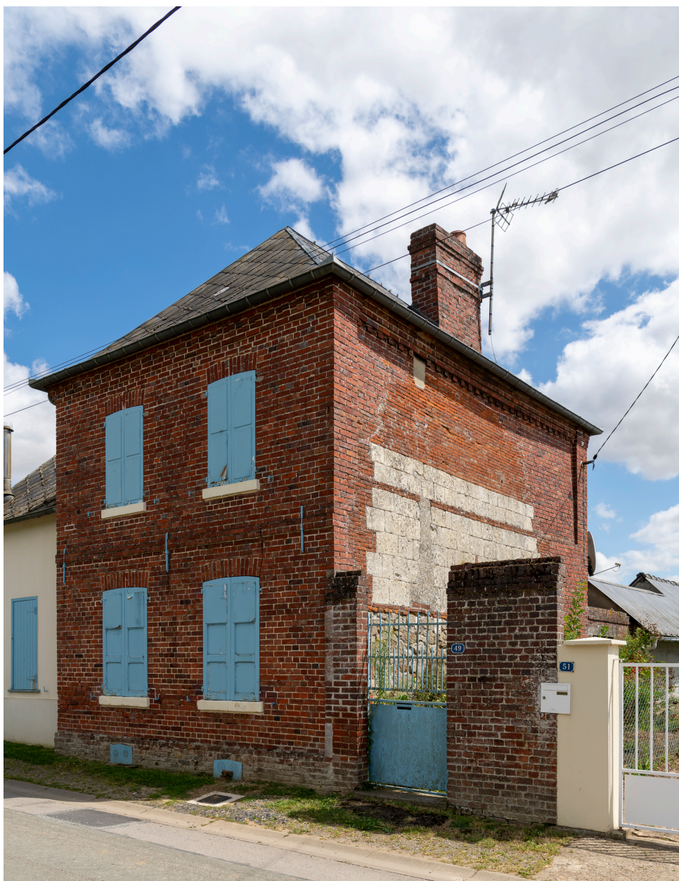
Logis en brique, n°49 de la rue de Montdidier, vue depuis l'ouest.
