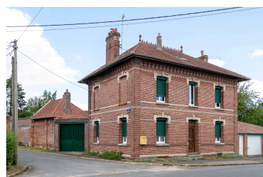
Demeure en brique, n°21 de la rue du Bail, vue depuis le sud. Phot. Marc Kérignard IVR32_20246000829NUCA
