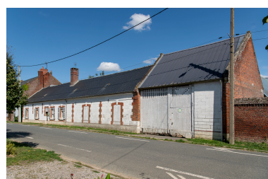
Logis d'une ferme à cour datée de 1814, n°46 de la Chaussée Brunehaut, vue depuis l'ouest. Phot. Marc Kérignard
