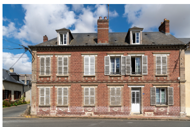
Demeure en brique, n°9 de la rue du Bail, vue depuis le sud. Phot. Marc Kérignard IVR32_20246000815NUCA
