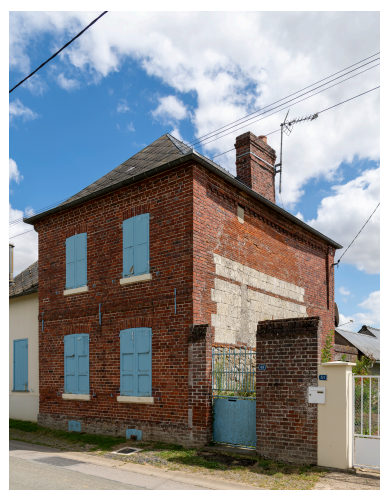
Logis en brique, n°49 de la rue de Montdidier, vue depuis l'ouest. Phot. Marc Kérignard IVR32_20246000818NUCA
