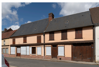
Anciens magasins de commerce, n°4 de la rue de la Halle, vue depuis le sud. Phot. Marc Kérignard IVR32_20246000806NUCA
