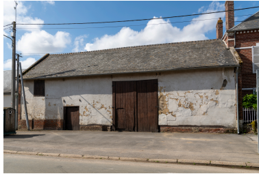
Grange d'une ferme à cour, n°49 de la Chaussée Brunehaut, vue depuis l'est. Phot. Marc Kérignard IVR32_20246000836NUCA
