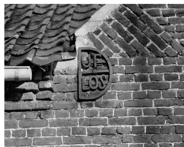
Détail du pignon des étables : fer d'ancrage patronymique Duflos. Phot. Philippe Dapvril IVR31_20055900032X
