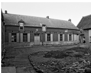
La cour : élévation antérieure du logis, donnant sur la cour. Phot. Philippe Dapvril IVR31_20055900034X
