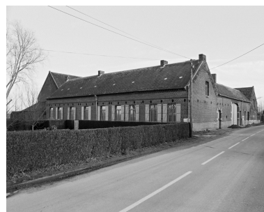
Vue générale de trois quarts de la ferme, côté logis. Phot. Philippe Dapvril IVR31_20055900033X
