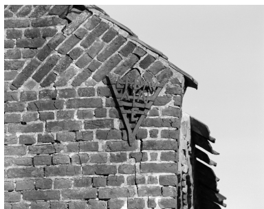
Détail du pignon des étables : fer d'ancrage patronymique Verdavaine. Phot. Philippe Dapvril IVR31_20055900043X
