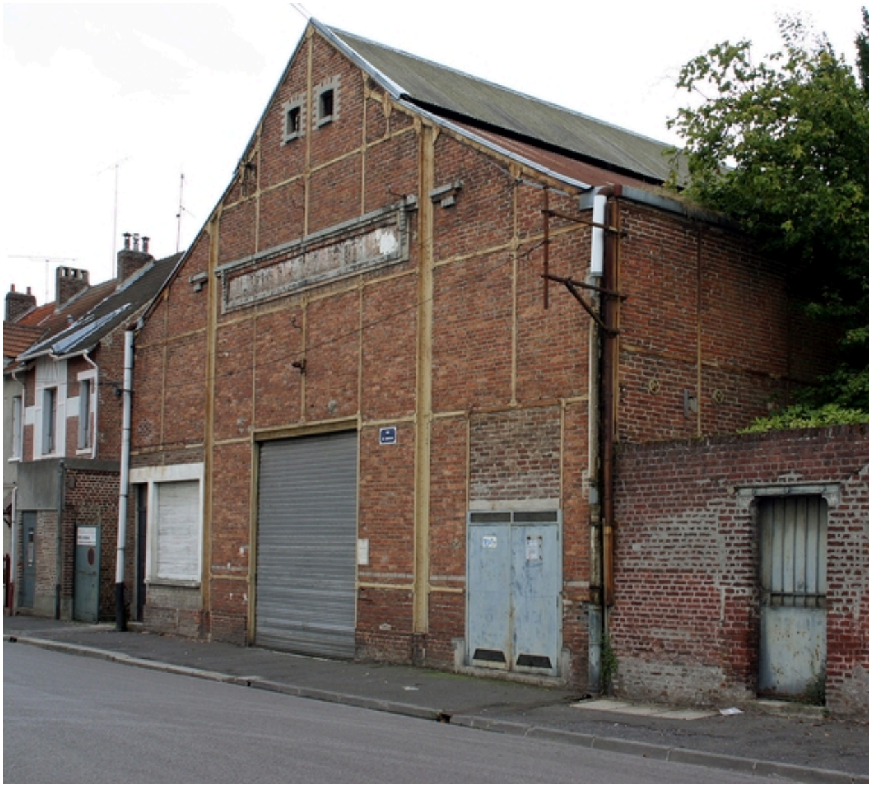
L'atelier construit en 1922.
