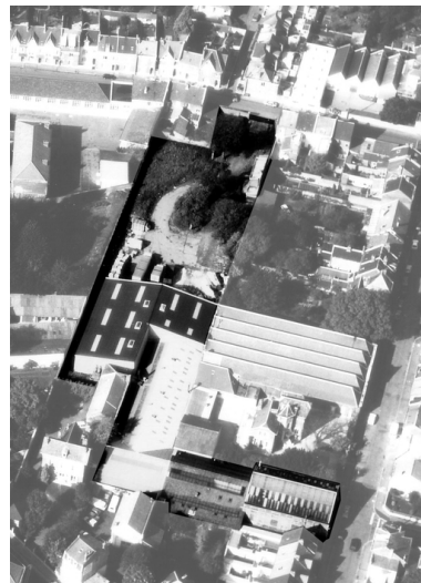
Vue aérienne du site en 1989. Phot. Pillet Frédéric, Autr. Phot'R IVR22_20040200895NUCA
