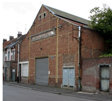
L'atelier construit en 1922. Phot. Frédéric Pillet IVR22_20040200900NUCA
