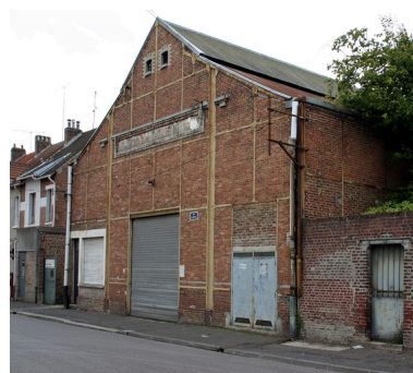
L'atelier construit en 1922. Phot. Frédéric Pillet IVR22_20040200900NUCA
