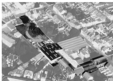
Vue aérienne du site en 1989. Phot. Pillet Frédéric, Autr. Phot'R IVR22_20040200896NUCA
