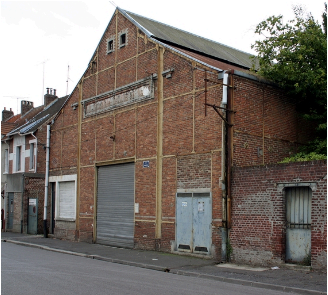
L'atelier construit en 1922.
