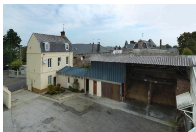
Vue du logement patronal de Mr. Delabie et d'une partie de la robinetterie. Phot. Thierry Lefébure IVR22_20148000483NUC2AQ
