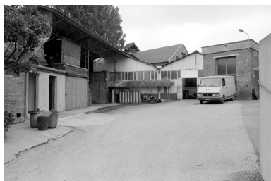
Atelier de fabrication et cour, en 1988. Phot. Benoît Dufournier IVR22_19918000132Z
