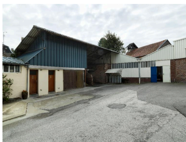
Vue des plus anciens locaux de la robinetterie Delabie. Phot. Thierry Lefébure IVR22_20148000482NUC2A
