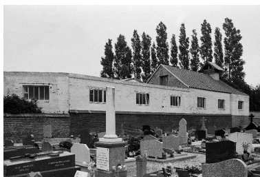
Ateliers anciens, flanc ouest, en 1990. Phot. Benoît Dufournier IVR22_19908000337Z
