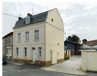
Vue du logement patronal de Mr Delabie et d'une partie de la robinetterie. Phot. Thierry Lefébure IVR22_20148000481NUC2A
