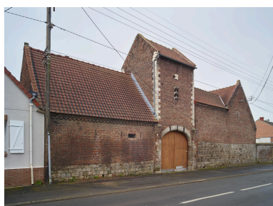
Façade de la ferme. Vue prise depuis la rue. Phot. Pierre Thibaut IVR32_20236200090NUCA
