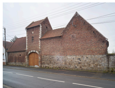
Façade de la ferme. Vue prise depuis la rue. Phot. Pierre Thibaut IVR32_20236200091NUCA
