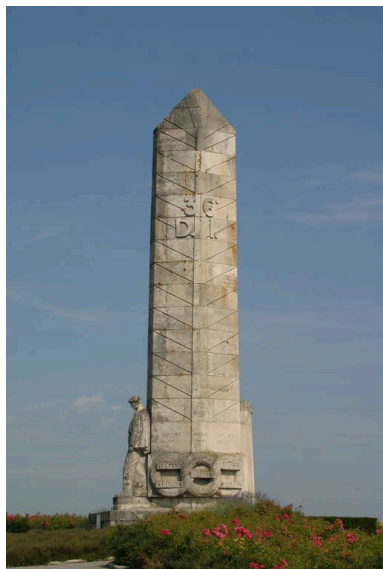
Vue générale du monument des Basques. Phot. Irwin Leullier IVR22_20030203188NUCA
