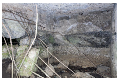
Intérieure du magasin à munitions Phot. Pierre Thibaut IVR31_20155901165NUCA
