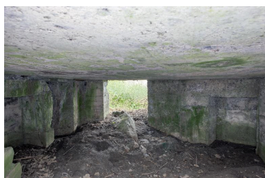
Vue vers le sud, depuis la chambre de tir Phot. Pierre Thibaut IVR32_20165900978NUCA
