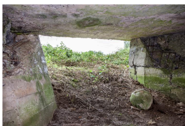
Vue vers le nord, depuis la chambre de tir Phot. Pierre Thibaut IVR32_20165900979NUCA
