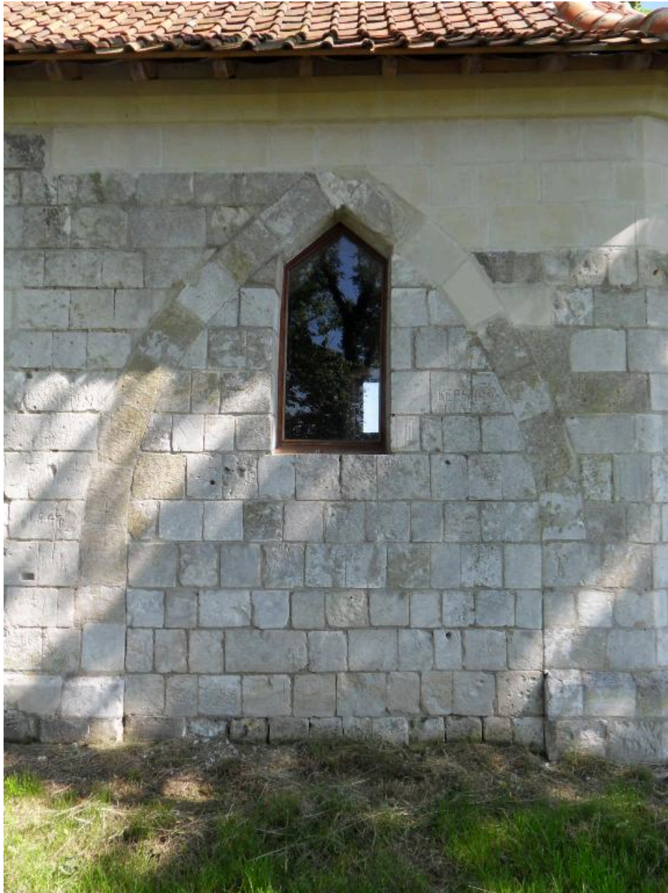
Troisième arcature mur sud.
