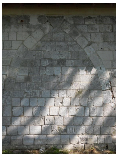
Deuxième arcature mur sud. Phot. Isabelle Barbedor IVR22_20108010156NUCA
