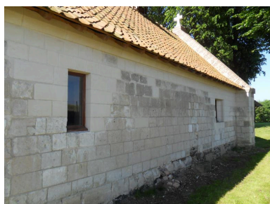
Mur nord. Phot. Isabelle Barbedor IVR22_20108010153NUCA
