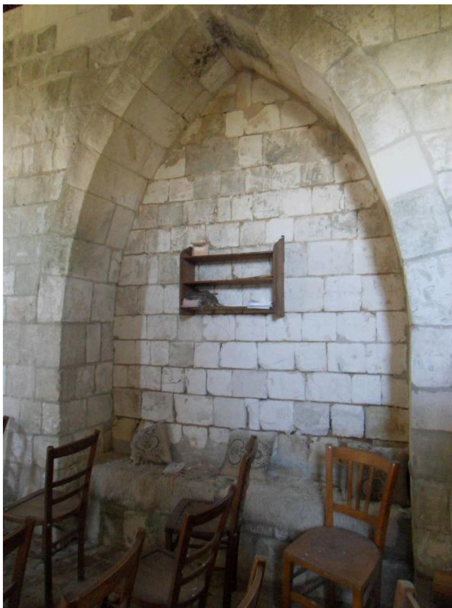
Vue intérieure, deuxième arcature (mur sud).
