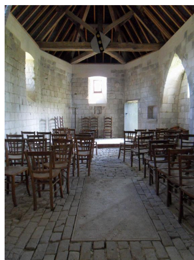
Vue intérieure vers le chœur. Phot. Isabelle Barbedor IVR22_20108010130NUCA
