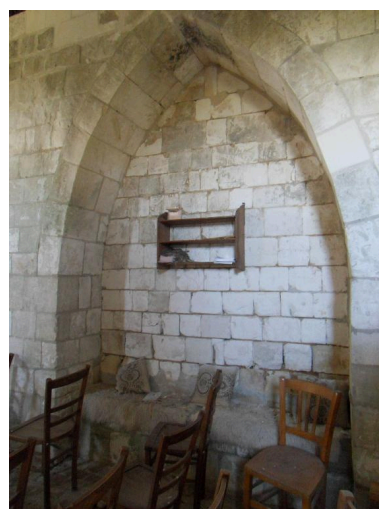
Vue intérieure, deuxième arcature (mur sud). Phot. Isabelle Barbedor IVR22_20108010132NUCA
