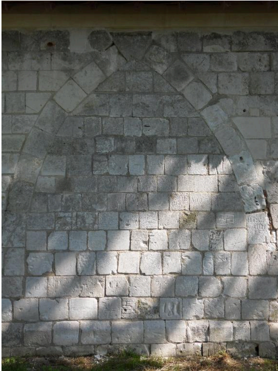
Deuxième arcature mur sud.
