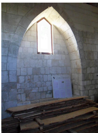
Vue intérieure. Première arcature (mur sud). Phot. Isabelle Barbedor IVR22_20108010133NUCA
