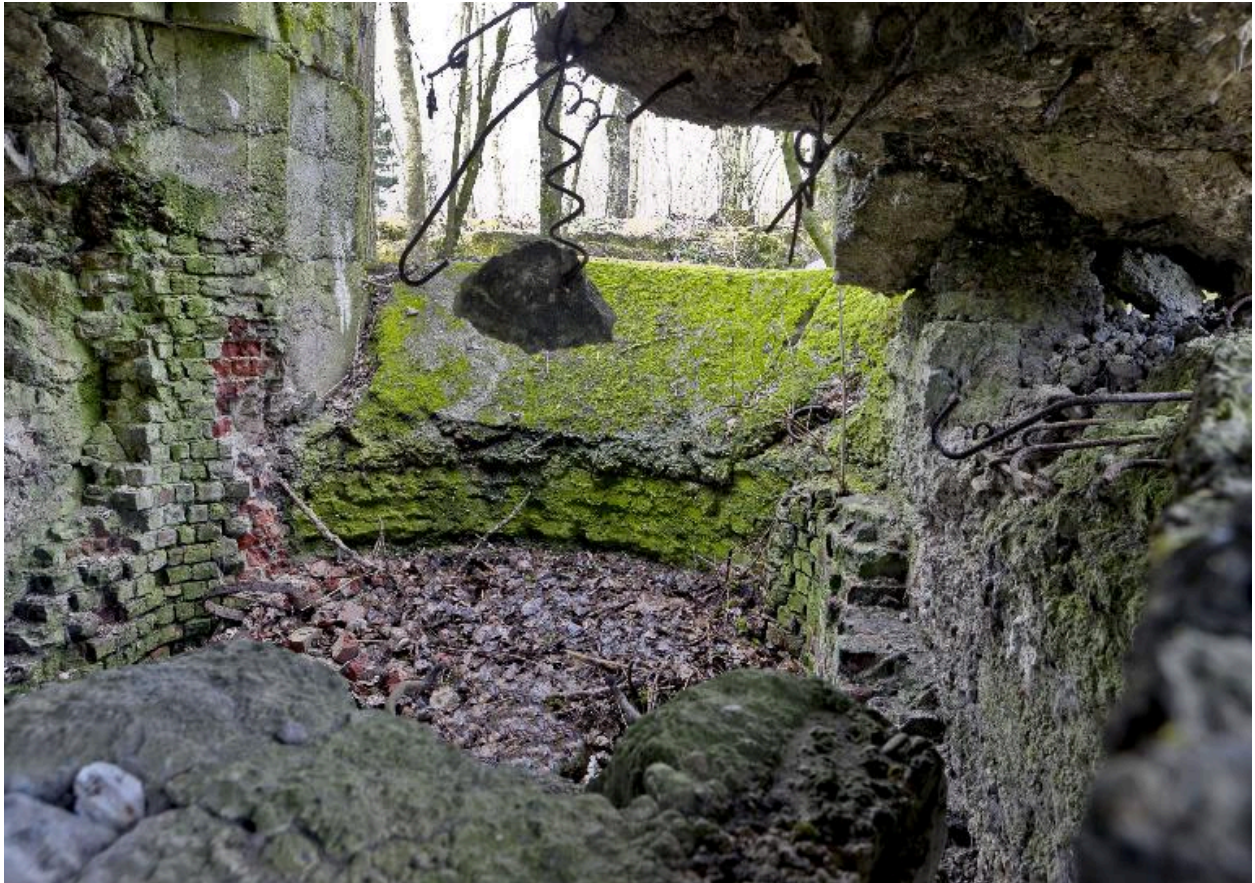
Vue intérieure, la cuve à canon
