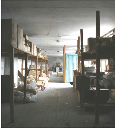
Vue intérieure des anciens magasins (aile gauche, 1er étage). Phot. Frédéric Pillet IVR22_20050206129NUCA
