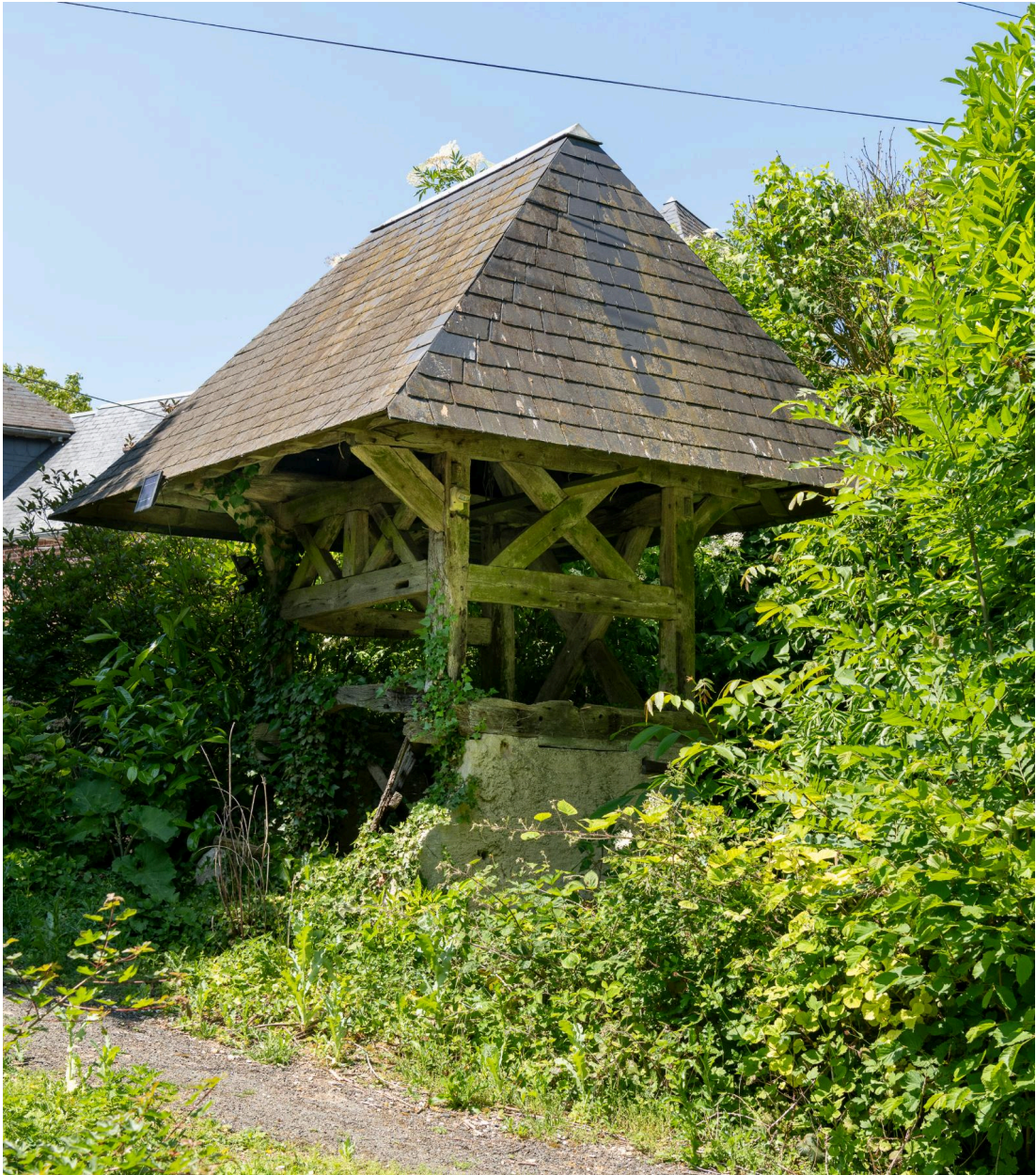
Puits, vue prise depuis le sud-est.
