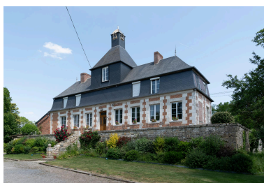
Logis, vue prise depuis le sud-ouest. Phot. Marc Kérignard IVR32_20236000804NUCA
