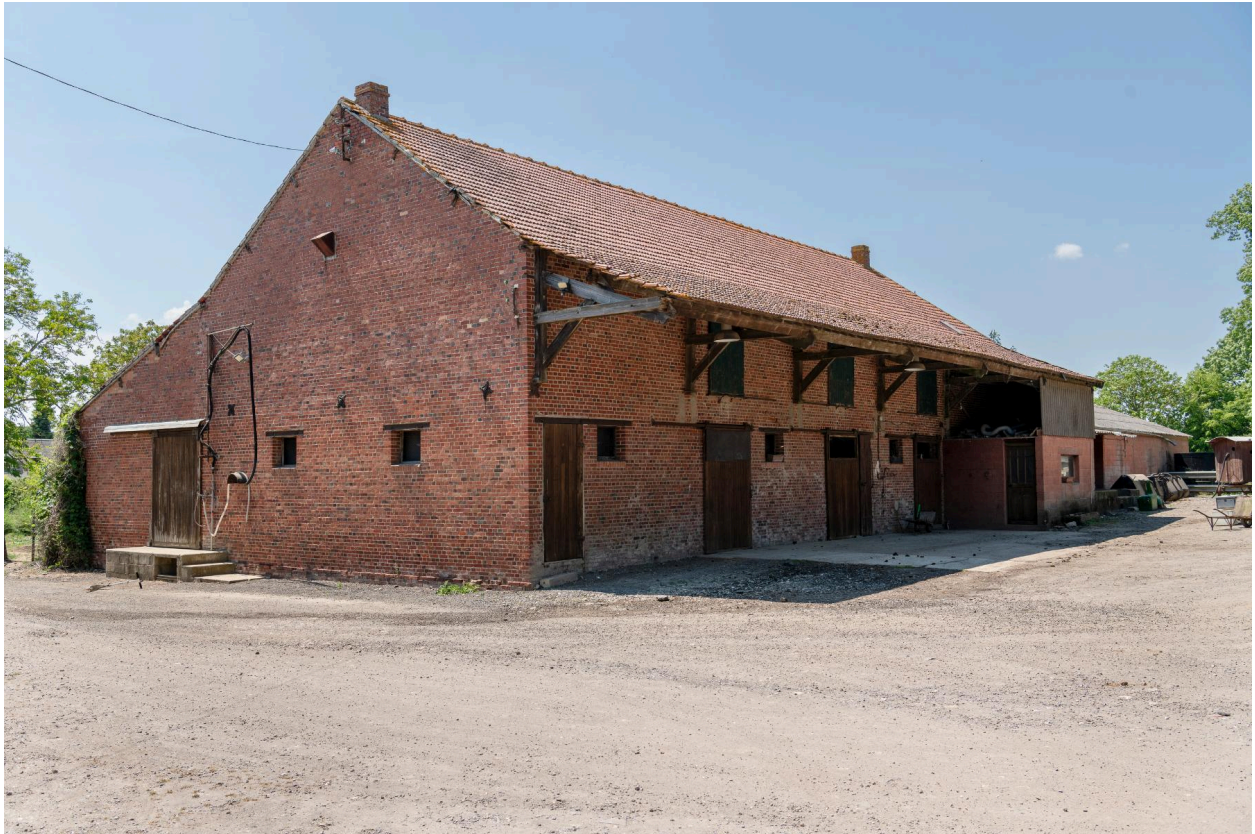
Vue des écuries prise depuis l'est.
