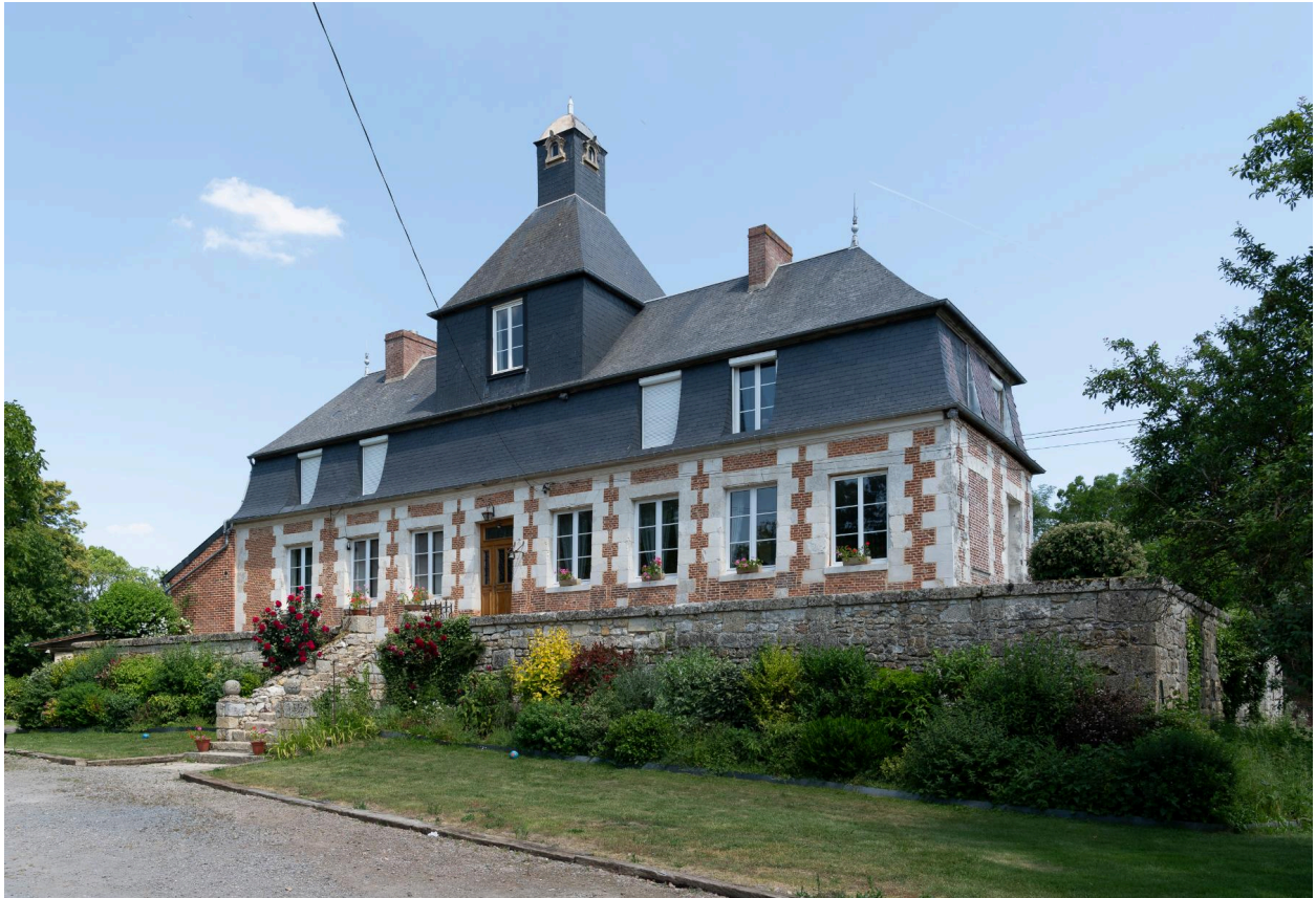
Logis, vue prise depuis le sud-ouest.
