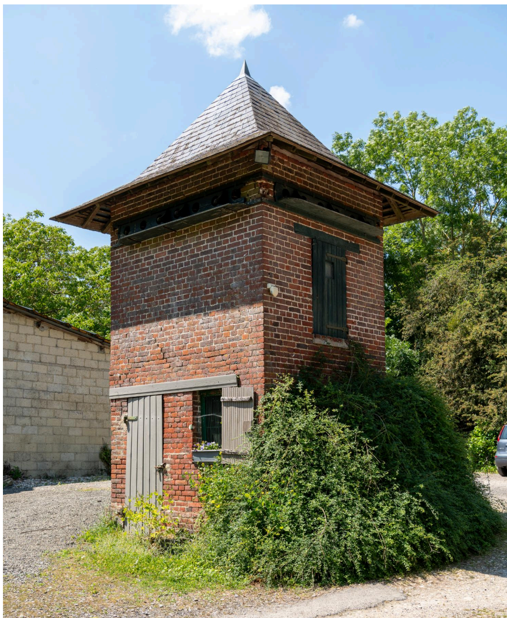
Pigeonnier, vue prise depuis le sud.
