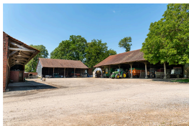
Vue générale prise depuis l'est des remises agricoles. Phot. Marc Kérignard IVR32_20236000798NUCA
