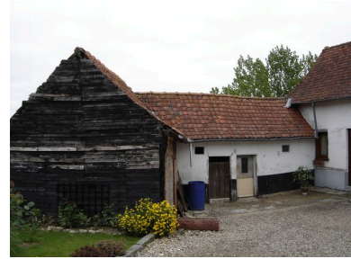
Vue des dépendances. Phot. Inès Guérin IVR22_20058005752NUCA
