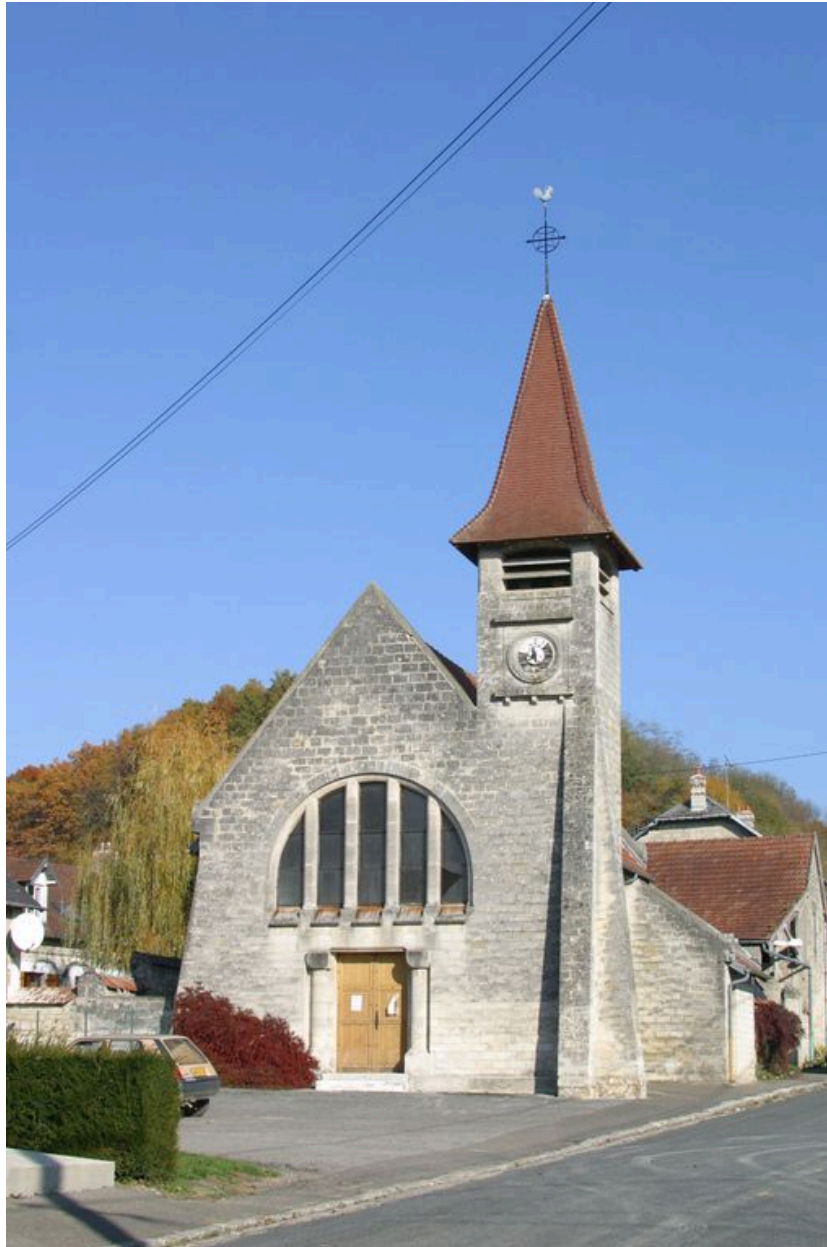
Vue générale de la façade ouest.
