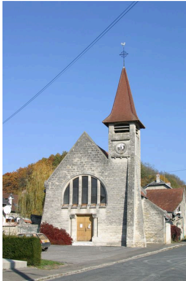
Vue générale de la façade ouest. Phot. Inès Guérin IVR22_20030201986NUCA
