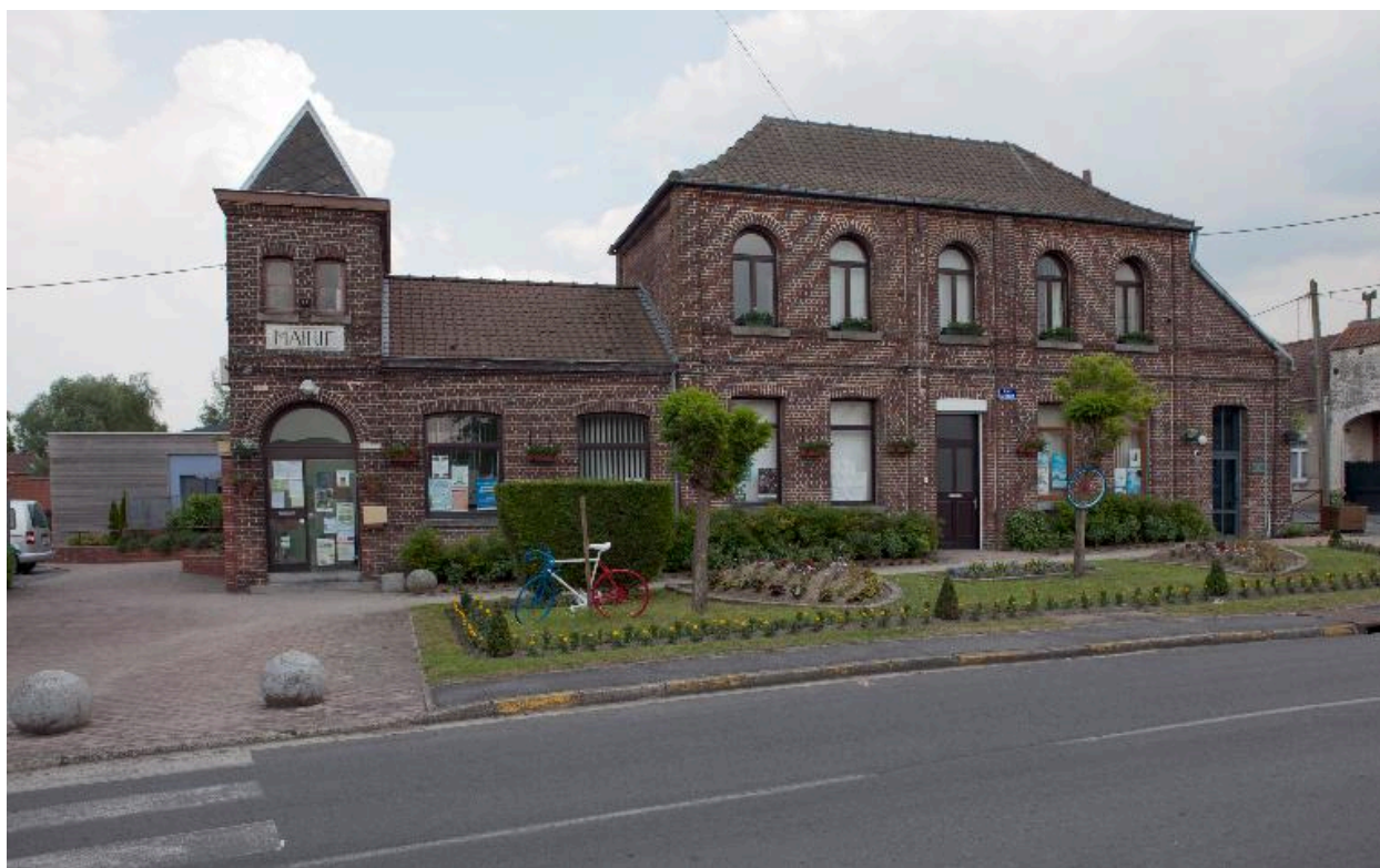
Vue générale de la façade antérieure.
