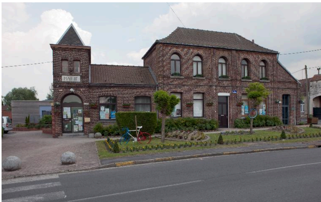
Vue générale de la façade antérieure.
