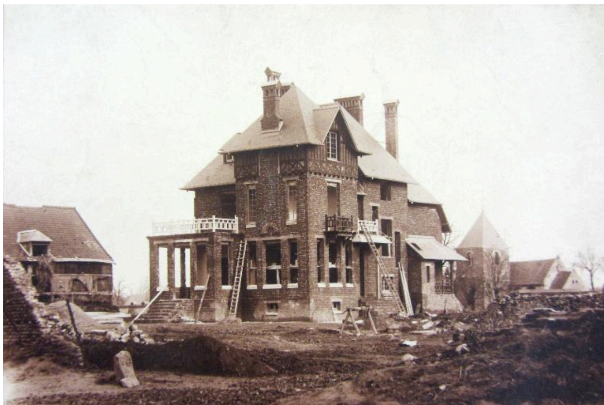
La maison de l'ingénieur agronome en cours de construction, mai 1921 (AD Somme ; 49 Fi 65).
