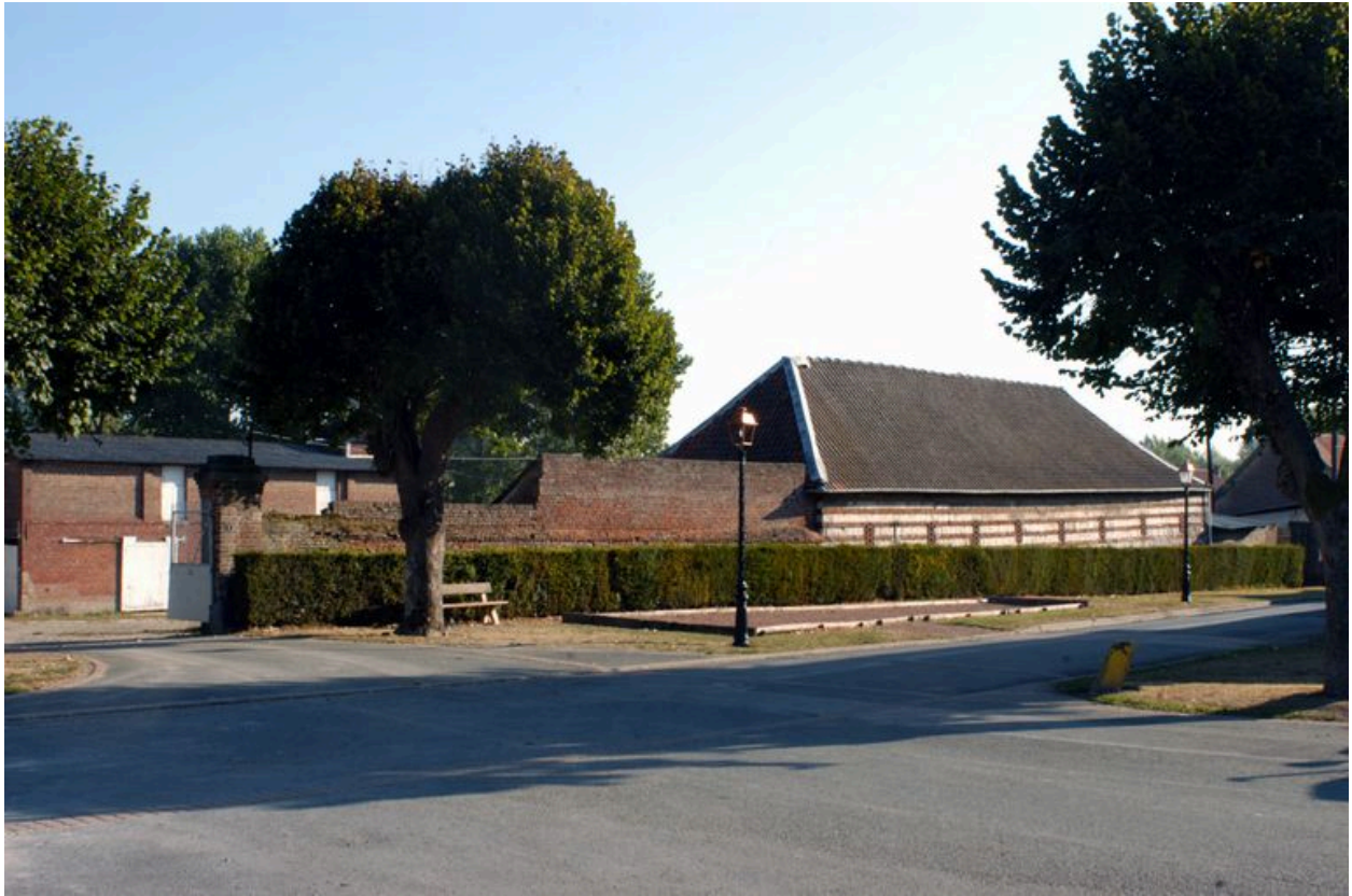
Dépendances agricoles fermant la cour au sud.
