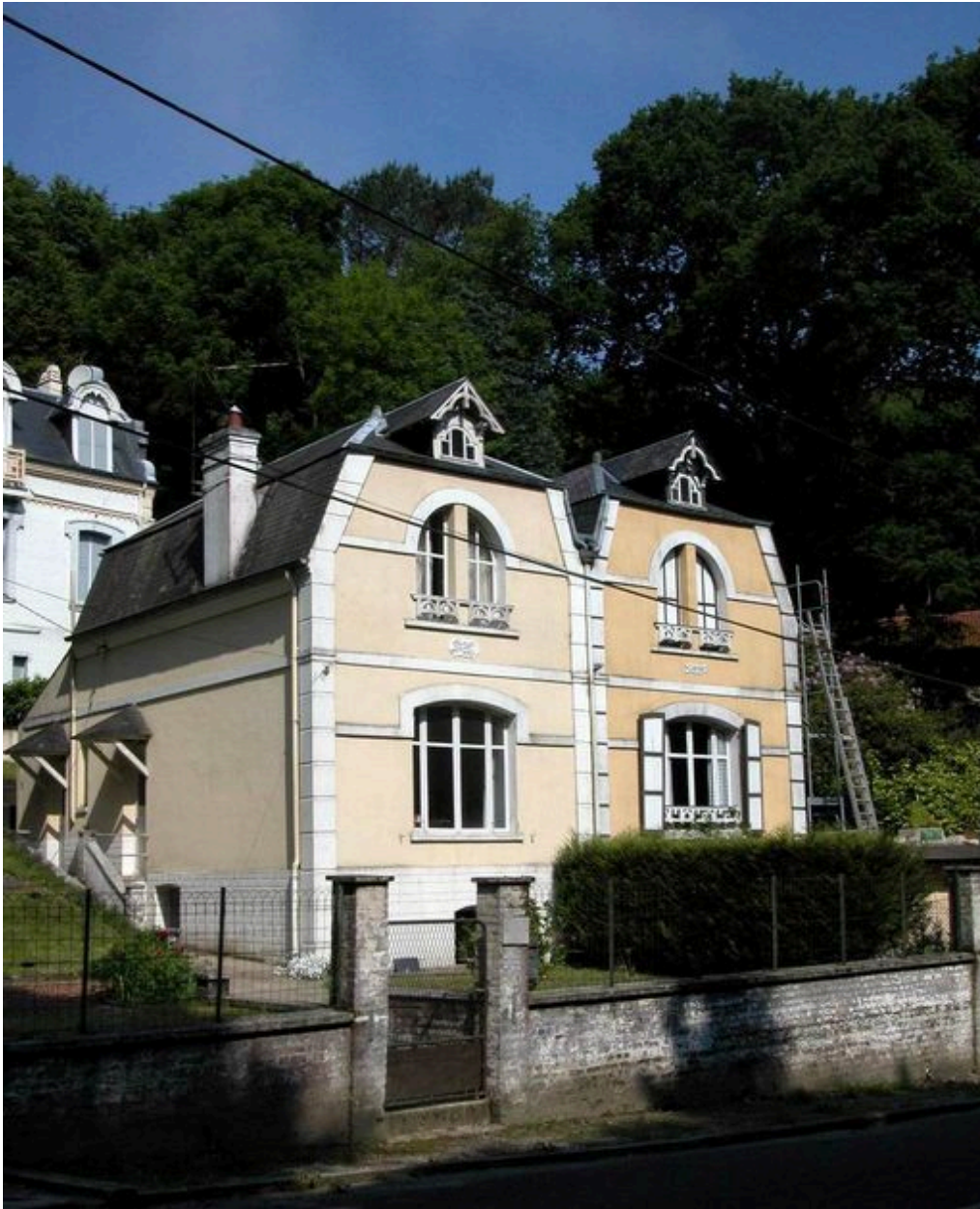
Vue d'ensemble depuis la rue.
