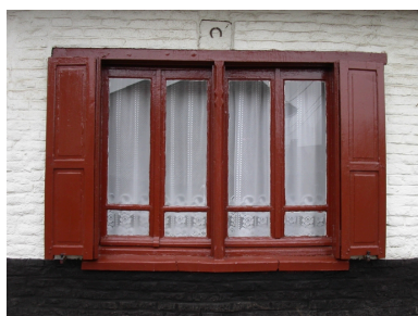
Logis situé 141, rue de Guivarniez, détail du châssis à meneau en bois. Phot. Cyril Cailleau IVR31_20055907507NUCA
