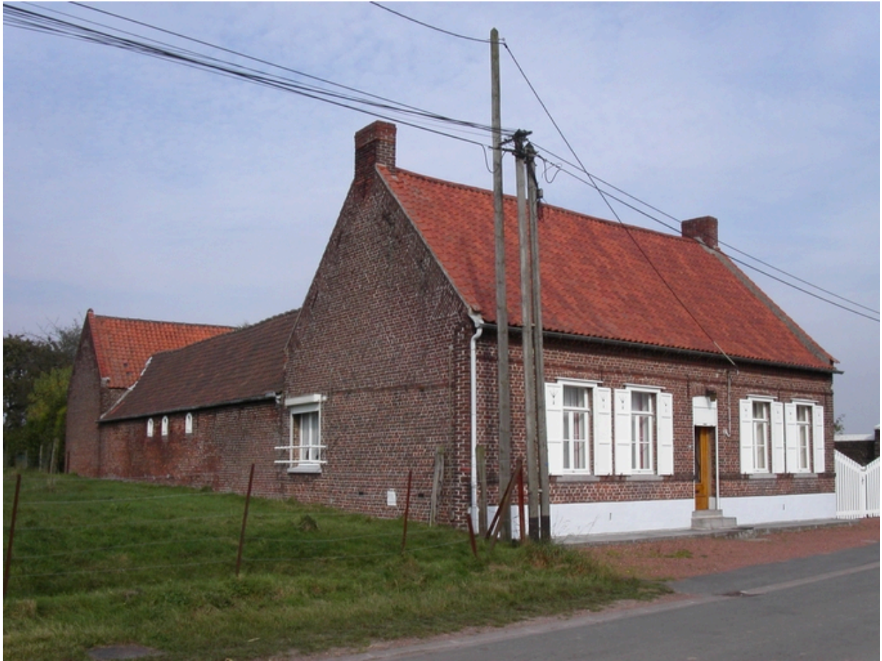
Ferme en U (ouverte latéralement), 982, rue du Hennoy, vue depuis la rue.
