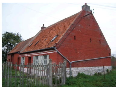
Ferme élémentaire, 339, rue de Guivarmez, vue depuis la rue. Phot. Cyril Cailleau IVR31_20055907496NUCA
