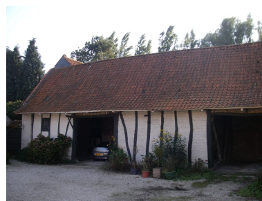
Grange de ferme (vestige de pan de bois et torchis) 562, rue Stanislas-Machynia, vue depuis cour. Phot. Cyril Cailleau IVR31_20055907499NUCA
