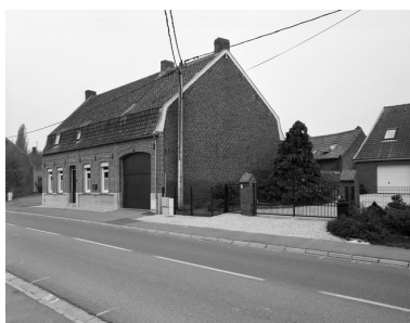
Maison d'artisan, 552, rue du Maréchal-Leclerc, vue depuis la rue. Phot. Philippe Dapvril IVR31_20085901081X
