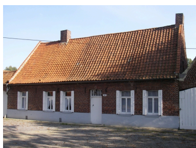
Logis de la ferme, 348, rue Stanislas-Machynia, vue depuis la rue. Phot. Cyril Cailleau IVR31_20055907493NUCA
