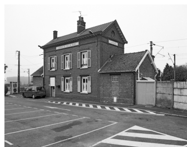
Gare de Landas, façade sur la place, rue du Maréchal-Leclerc (19e). Phot. Philippe Dapvril IVR31_20085901110X
