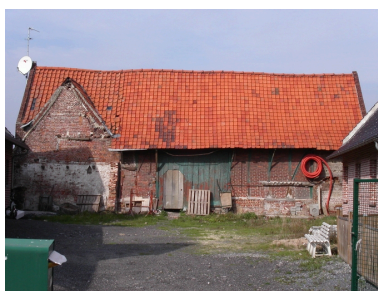
Grange de ferme remaniée (vestige de pan de bois) 1337, rue du Hennoy, vue depuis la rue. Phot. Cyril Cailleau IVR31_20055907498NUCA
