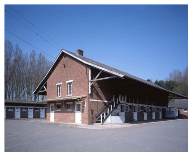
Les haras du Hennoy : des écuries construites vers 1950. Phot. Pierre Thibaut IVR31_20095902010VA
