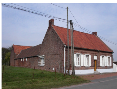
Ferme en U (ouverte latéralement), 982, rue du Hennoy, vue depuis la rue. Phot. Cyril Cailleau IVR31_20055907495NUCA
