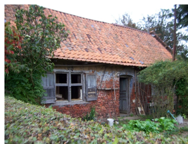
289, rue de la Pulmez : façade sur jardin, détail du logis (à l'abandon). Phot. Cyril Cailleau IVR31_20055907506NUCA
