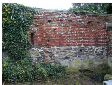
Ferme située 525, rue du Hennoy, vestige d'étables (soubassement en calcaire carbonifère) depuis la cour. Phot. Cyril Cailleau IVR31_20055907503NUCA
