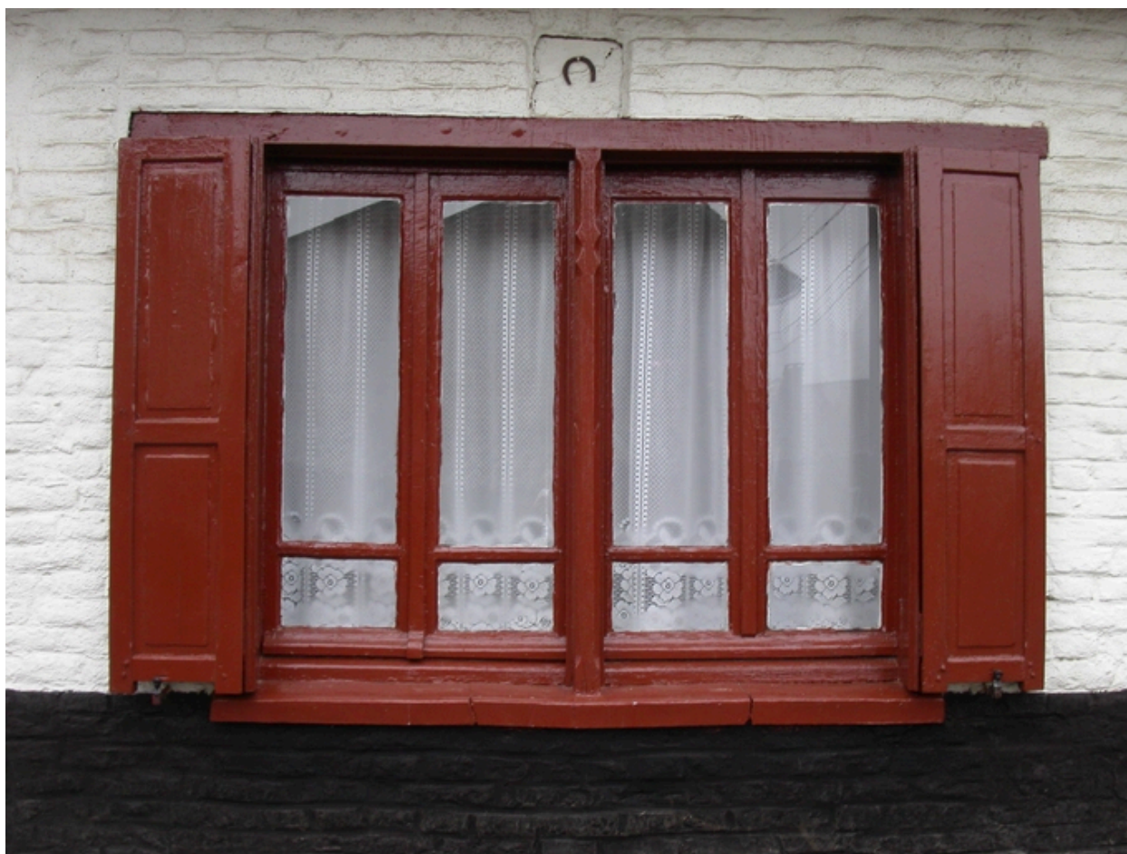
Logis situé 141, rue de Guivarmez, détail du châssis à meneau en bois.
