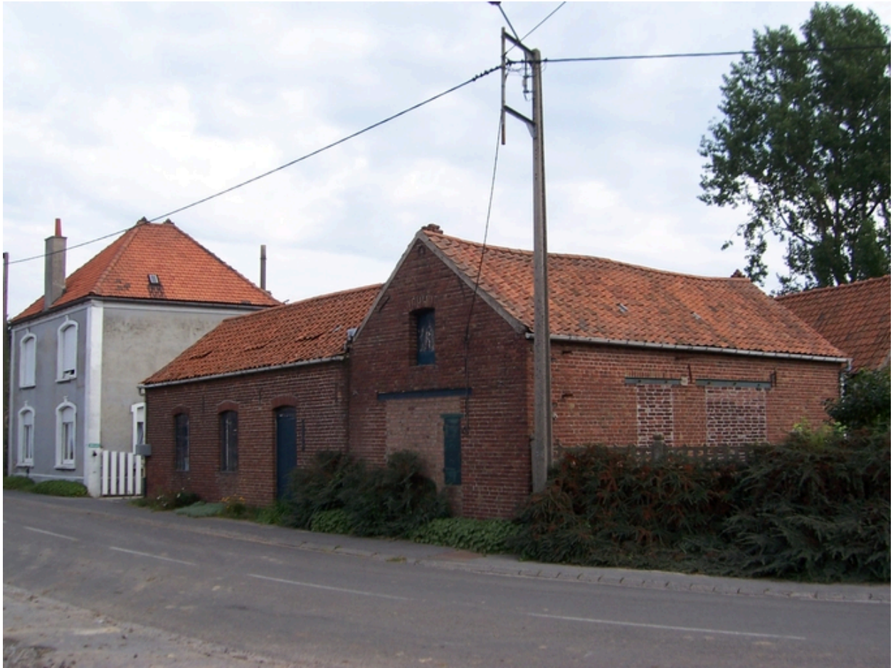
Atelier de charron-tonnelier-forgeron, 638, rue du Général-de-Gaulle, vue depuis la rue.
