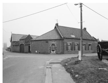
Oratoire ND de la Salette et logis de la ferme, 8, rue Guillocourt, vue depuis la rue. Phot. Philippe Dapvril IVR31_20085901091X
