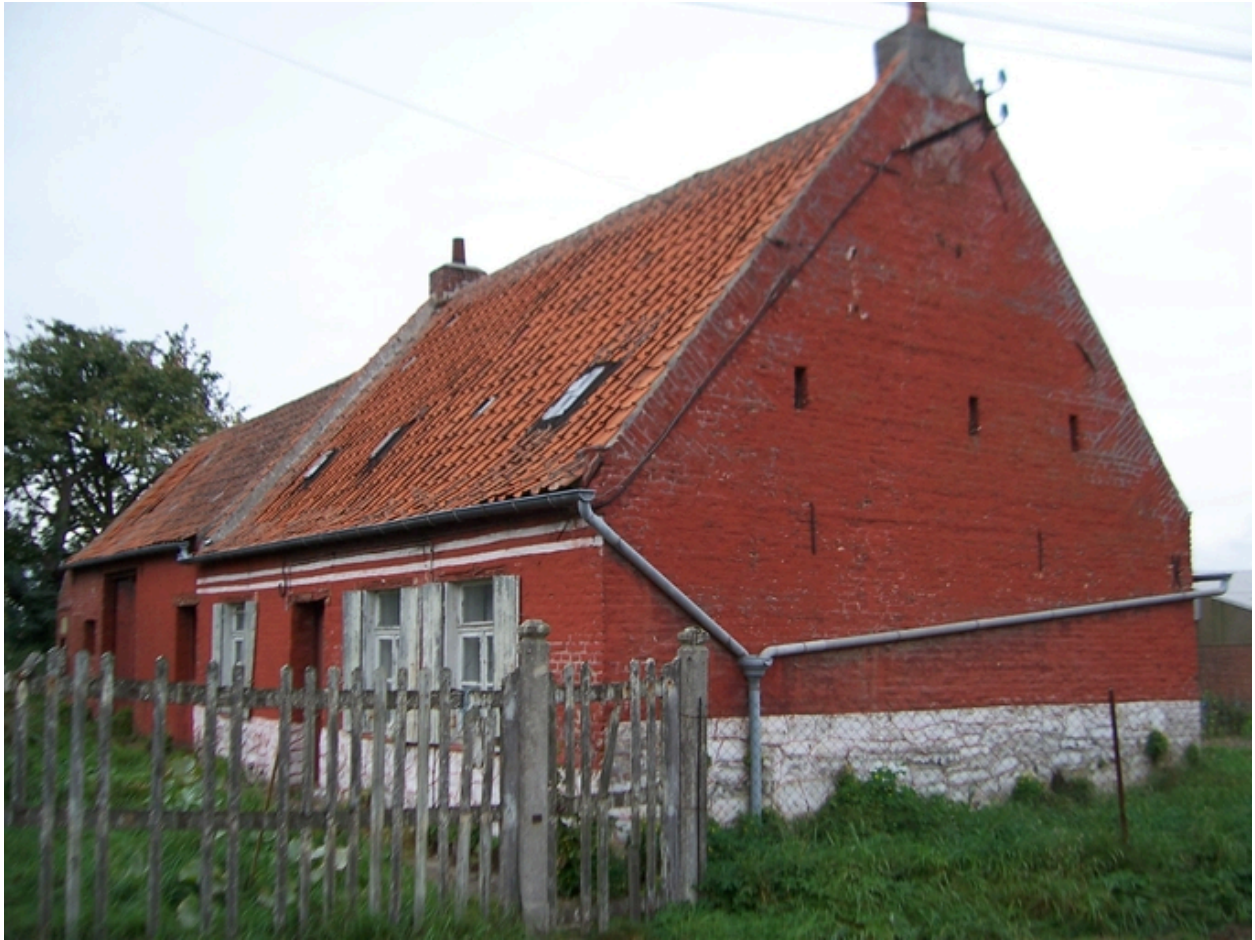
Ferme élémentaire, 339, rue de Guivarmez, vue depuis la rue.
