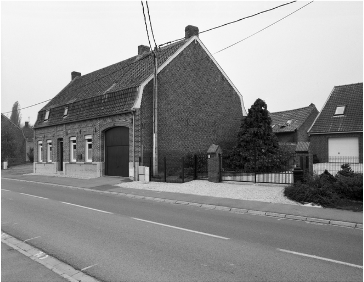
Maison d'artisan, 552, rue du Maréchal-Leclerc, vue depuis la rue.
