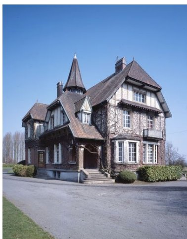
Villa du Haras du Hennoy, vue depuis la cour. Phot. Pierre Thibaut IVR31_20095902014VA
