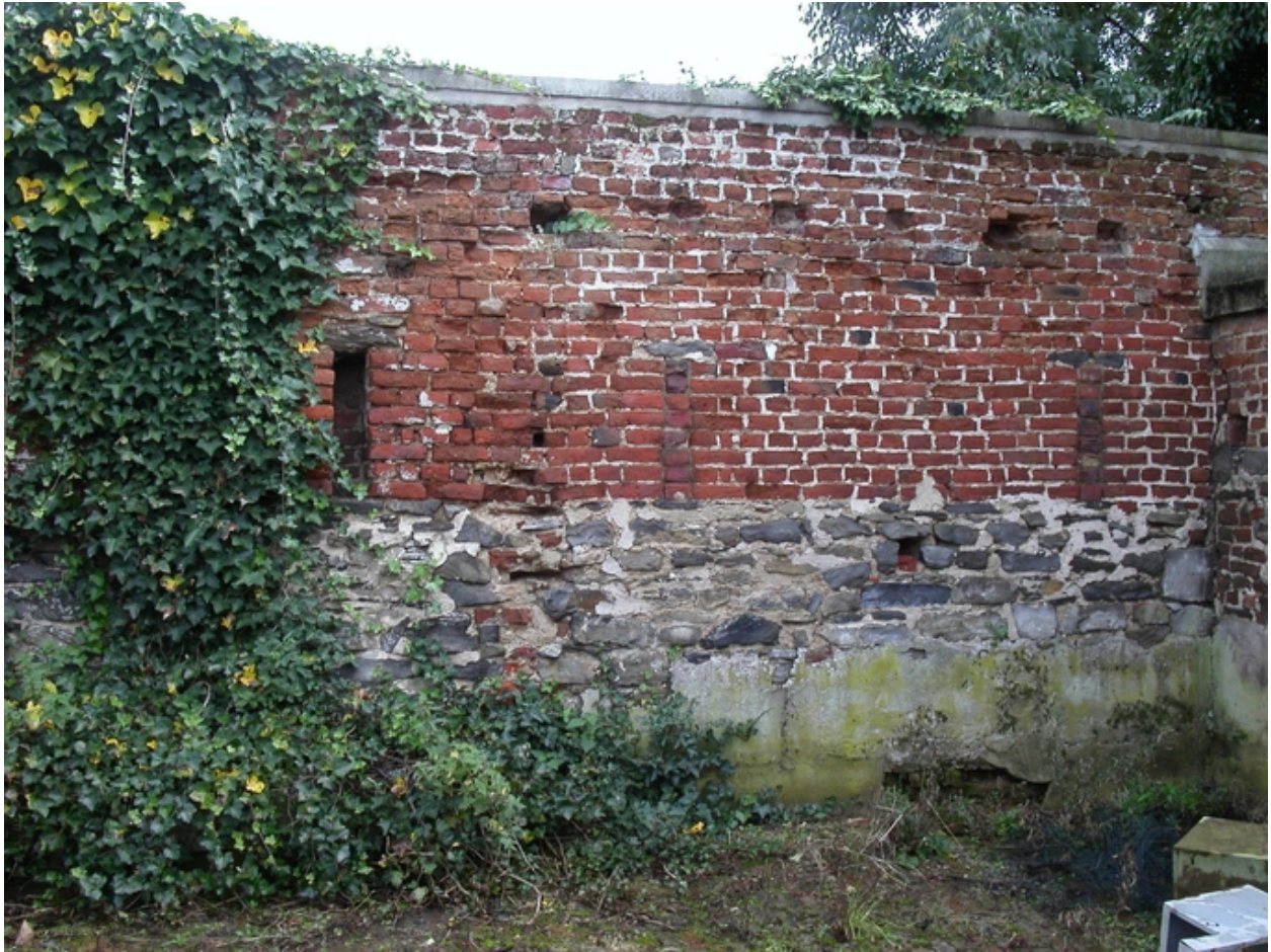
Ferme située 525, rue du Hennoy, vestige d'étables (soubassement en calcaire carbonifère) depuis la cour.
