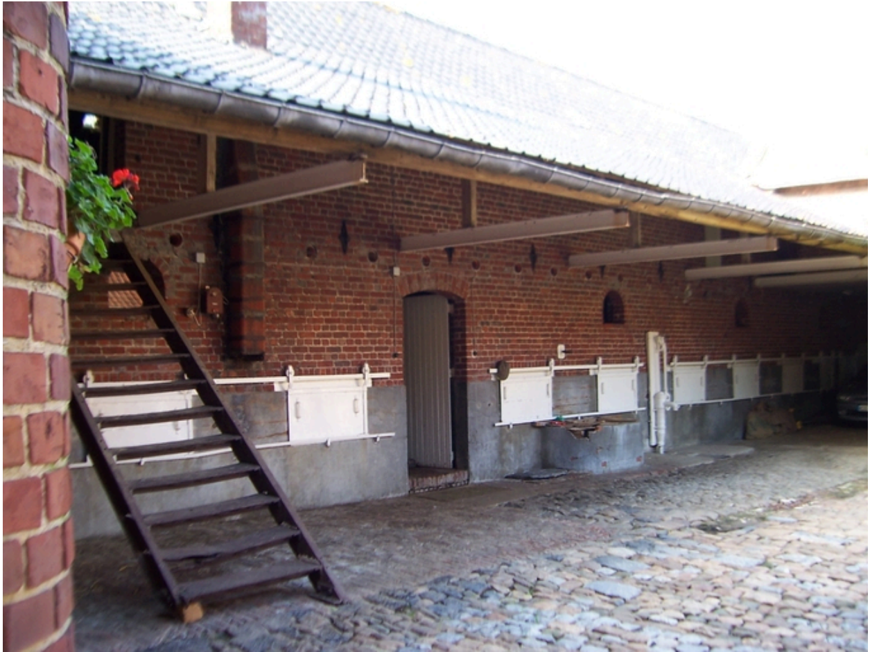
Ferme située 1558, rue du Quesne, étables-écuries depuis la cour.
