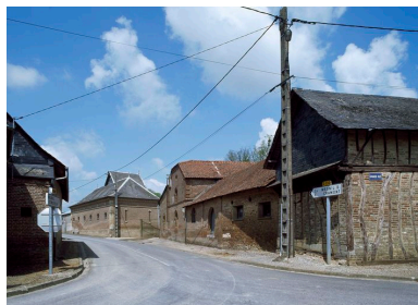
Alignement des bâtiments de la ferme et des écuries sur la rue Madame. Phot. Marie-Laure Monnehay-Vulliet IVR22_20108000164XA
