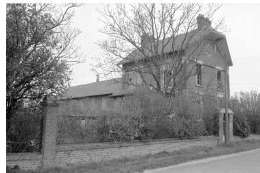
Logement patronal. Phot. Benoît Dufournier IVR22_19888000566Z
