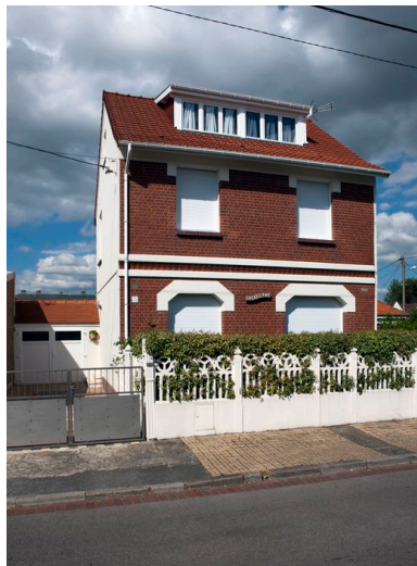
Vue générale. Phot. Pierre Thibaut IVR31_20146202217NUCA
