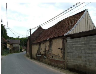
Ferme, 12 rue de Mouflers : vue depuis la rue des bâtiments en torchis. Phot. Frédéric Fournis IVR22_20098005295NUCA
