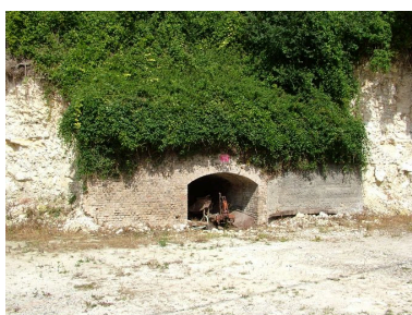
Entrée de l'ancienne carrière de pierre, rue de Mouflers.
