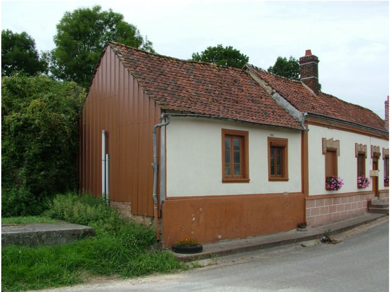
Ancienne école intégrée dans l'ancienne ferme, 8 rue de Haut.
