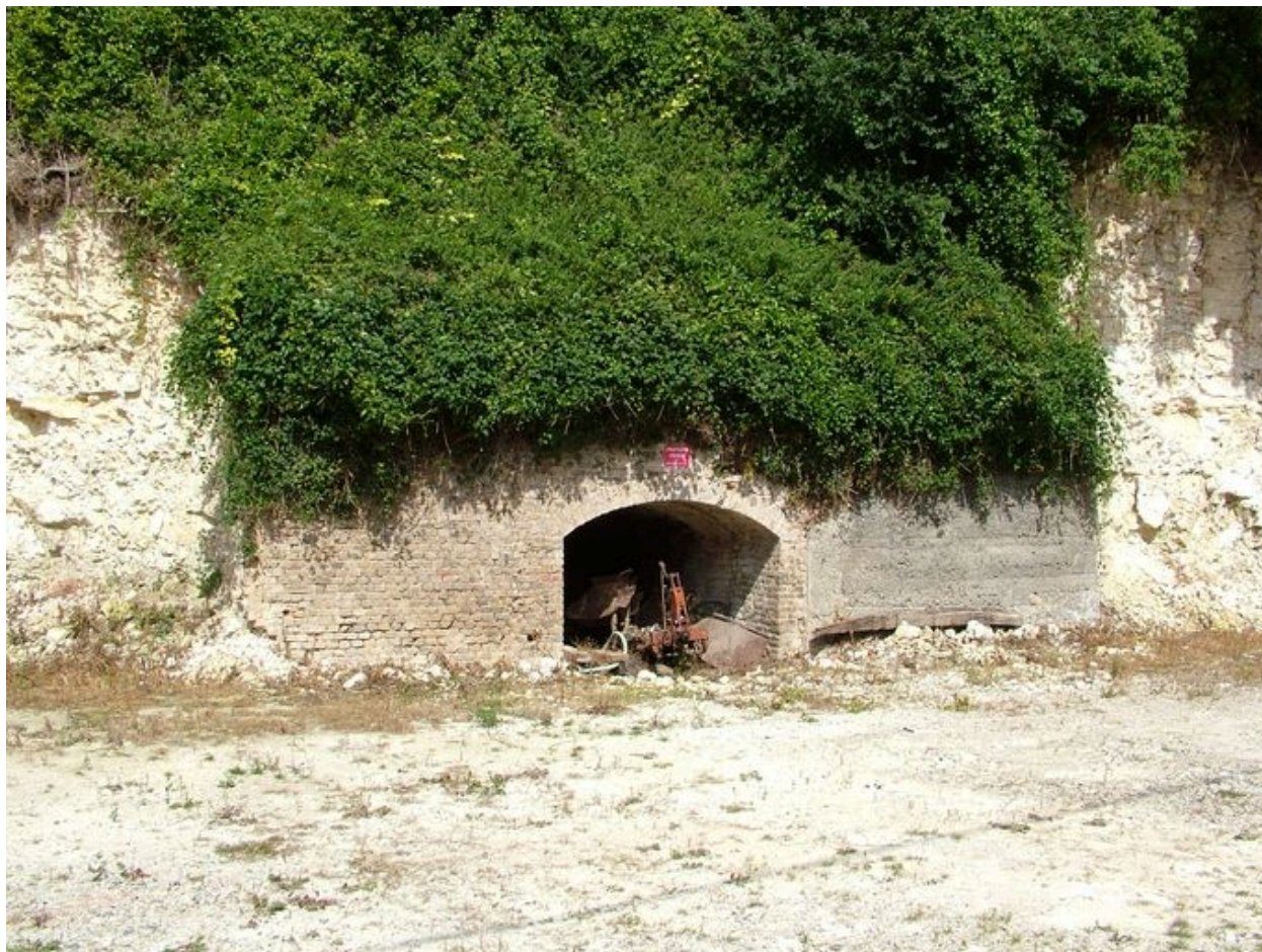
Entrée de l'ancienne carrière de pierre, rue de Mouflers.
