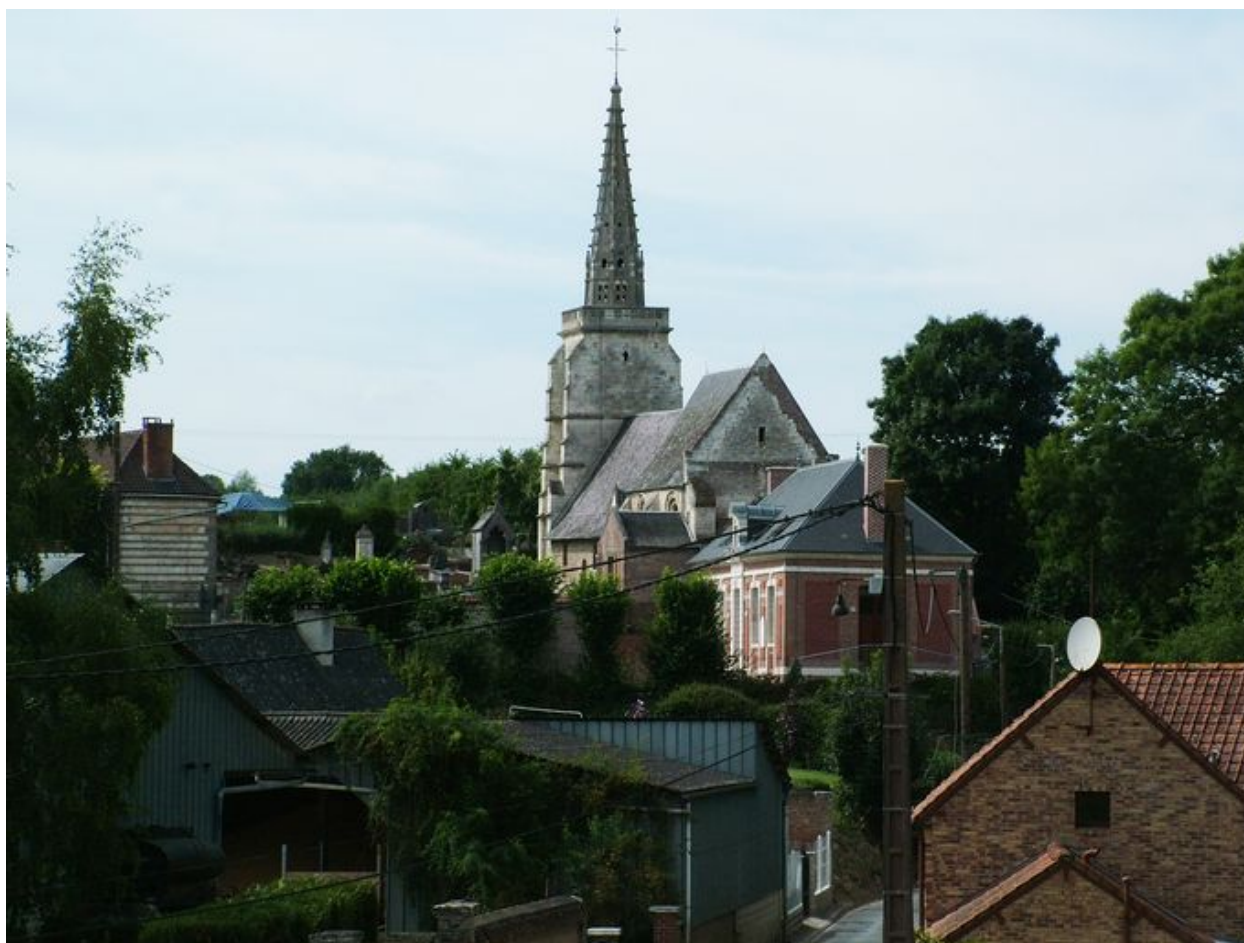
Vue du village depuis le sud-est, avec l'église et la mairie à l'arrière plan.
