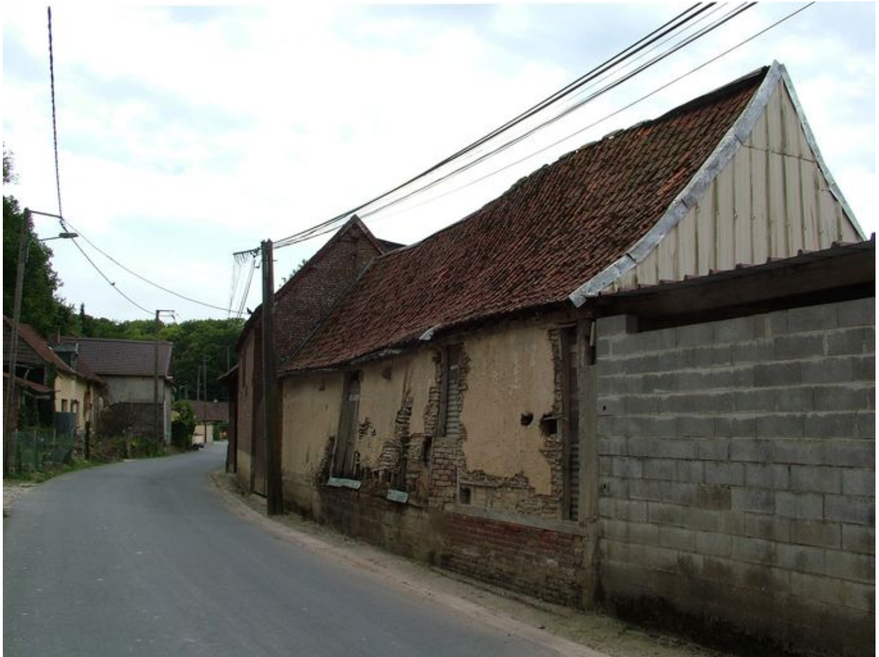
Ferme, 12 rue de Mouflers : vue depuis la rue des bâtiments en torchis.
