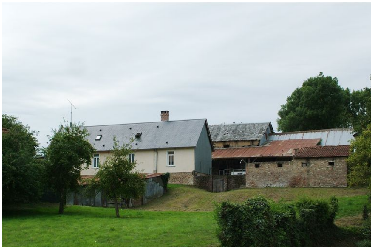
Vue arrière de la ferme, 3 rue de Haut, 19e siècle.
