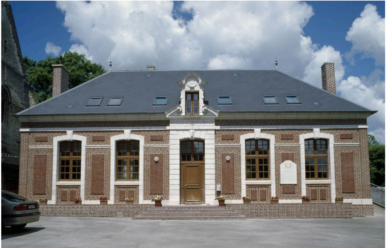
La mairie de Bouchon (ancienne école mairie).
