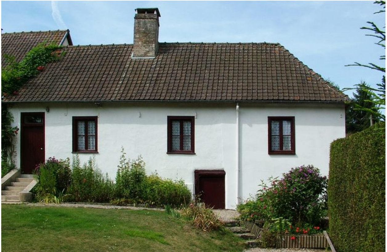
Vue du logis de l'ancienne ferme, 1 rue de Long, 1ère moitié du 19e siècle.
