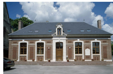
La mairie de Bouchon (ancienne école mairie).
