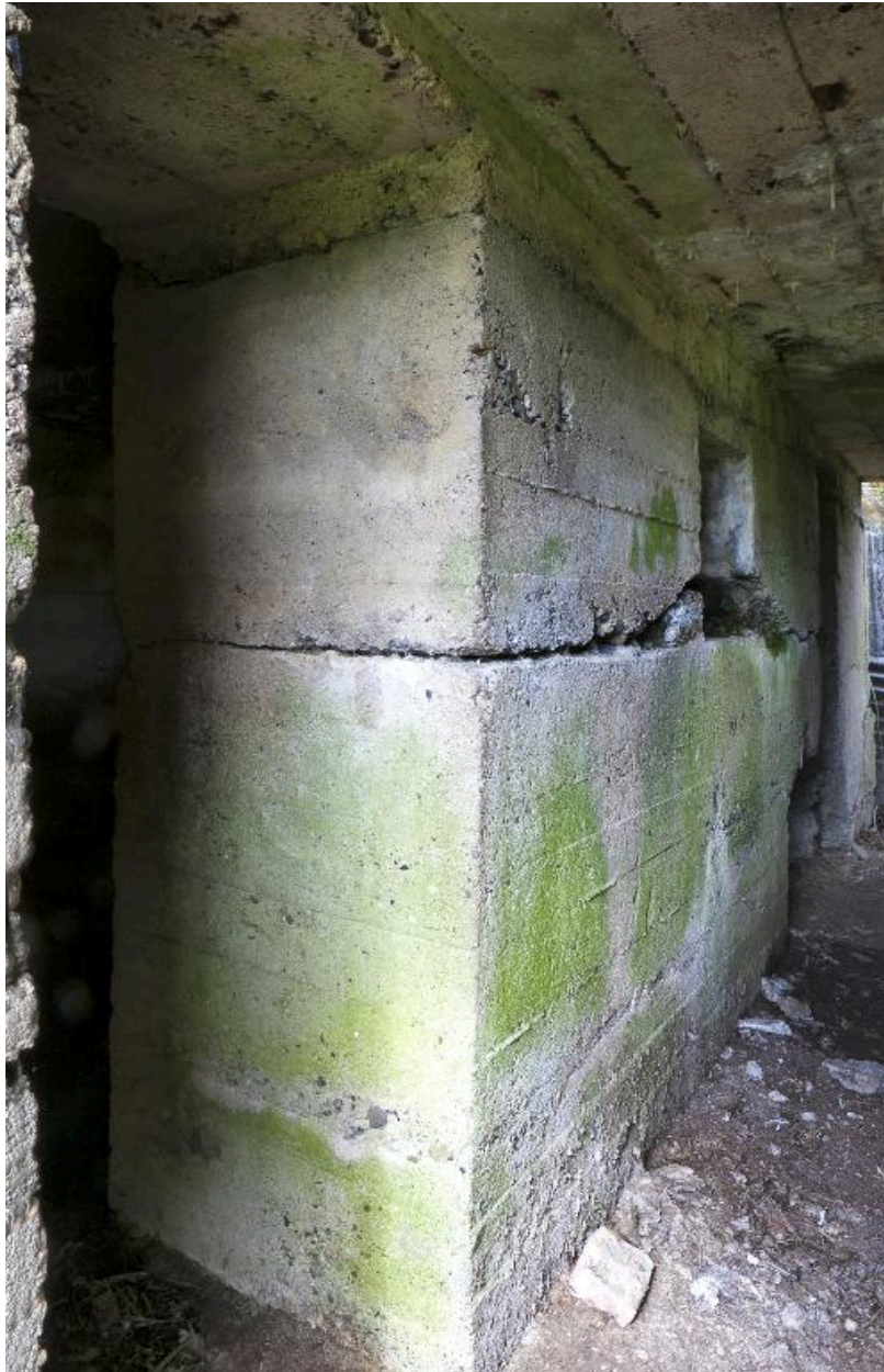
Couloir de distribution, accès à la salle Sud
