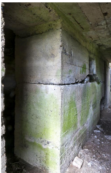
Couloir de distribution, accès à la salle Sud Phot. Jean-Marc Ramette
