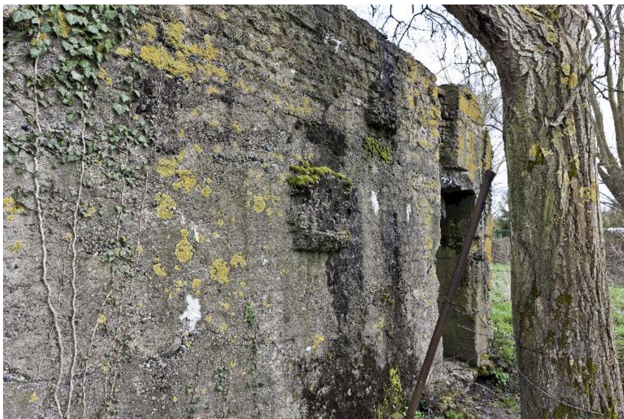
Elévation Sud-Ouest. Au fond l'accès au couloir de distribution
