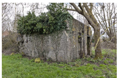
Vue vers l'Est Phot. Jean-Marc Ramette IVR31_20145904318NUCA
