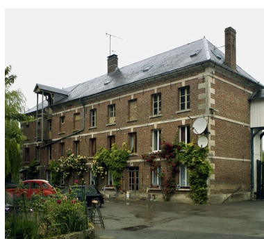
Façade sur cour de la minoterie. Phot. Thierry Lefébure IVR22_20056000179NUCA
