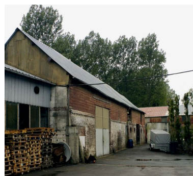
Dépendance agricole et étable. Phot. Thierry Lefébure IVR22_20056000184NUCA
