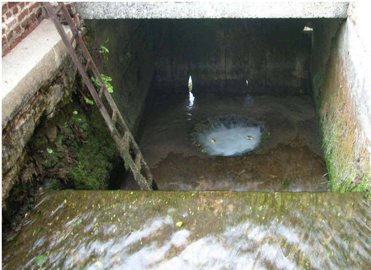
La chute et l'emplacement de la turbine du moulin.
