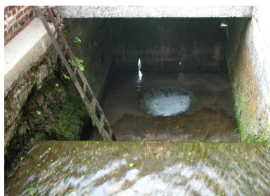
La chute et l'emplacement de la turbine du moulin. Phot. Bertrand Fournier IVR22_20056000790NUCA
