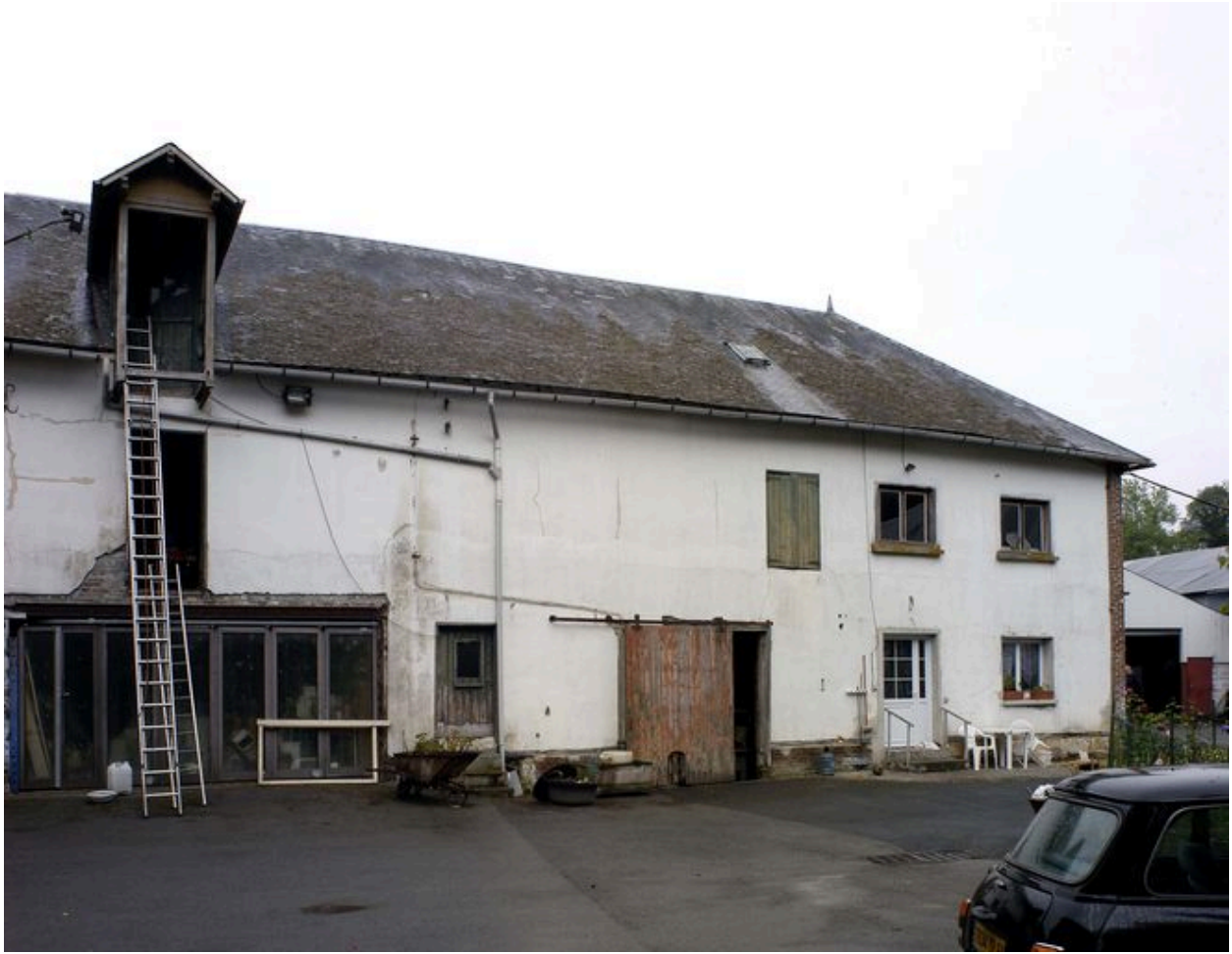
La grange et la remise, façade sur cour.
