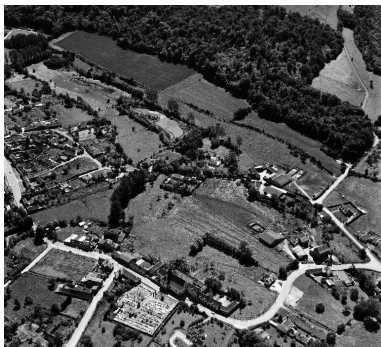
Vue aérienne, flanc sud. Phot. Phot'R IVR22_19888001201P
