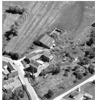
Vue aérienne, flanc sud. Phot. Phot'R IVR22_19888001200P
