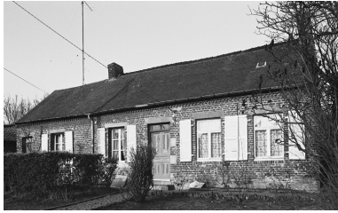
Vue d'ensemble de la façade. Phot. Christiane Riboulleau IVR22_19920201682Z
