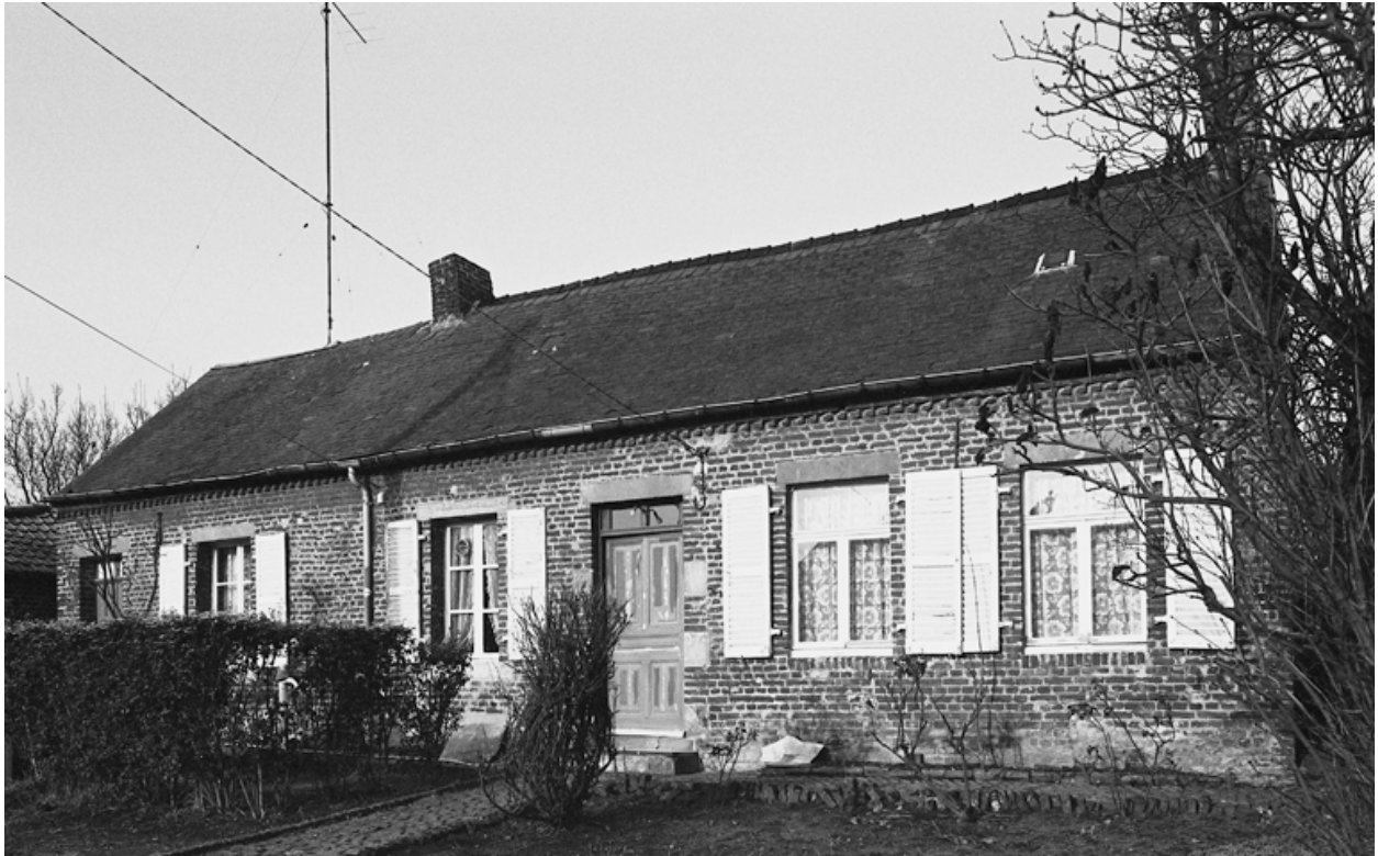
Vue d'ensemble de la façade.
