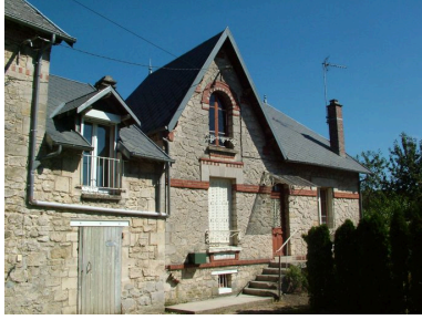
Vue générale. Phot. Inès Guérin IVR22_20030202497NUCA
