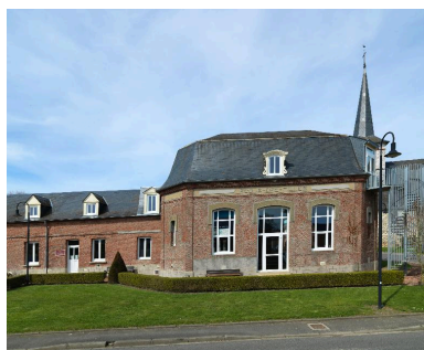
L'aile droite occupée par l'ancienne école de filles. Phot. Thierry Lefébure IVR22_20138000127NUC2A
