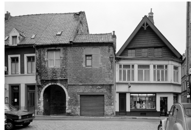
Vue générale sur voie. Phot. Jean-Michel Périn, Phot. Éric Dessert IVR31_19806204026X
