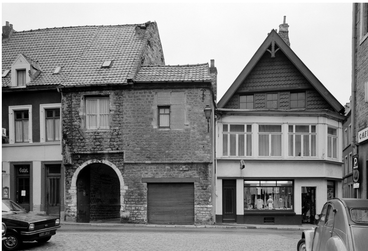
Vue générale sur voie.
