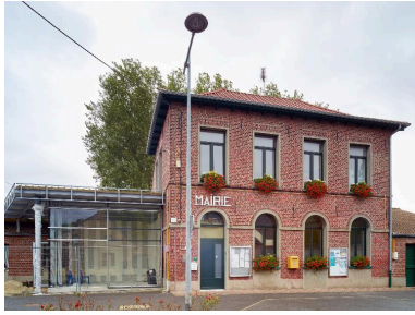
Vue générale. Phot. Pierre Thibaut IVR31_20155901634NUCA
