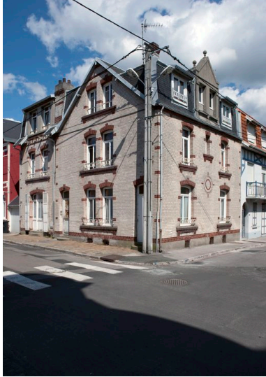
Vue générale. Phot. Pierre Thibaut IVR31_20146202208NUCA
