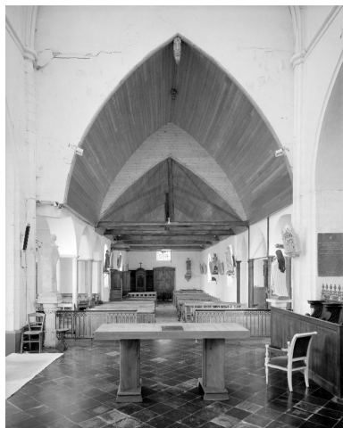
Vue intérieure de l'église, depuis le chœur. Phot. Irwin Leullier IVR22_19978000938V
