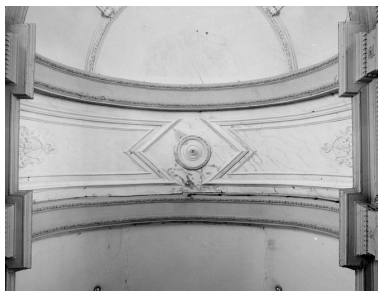
Détail des moulures en stuc, à l'entrée du chœur. Phot. Thierry Lefébure IVR22_19968000248X
