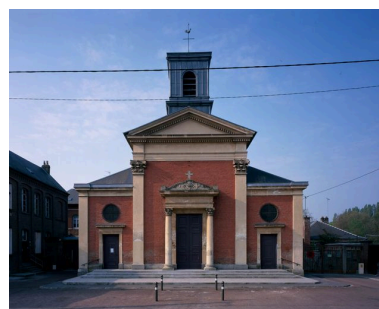
Vue générale. Phot. Thierry Lefébure IVR22_20038000389VA
