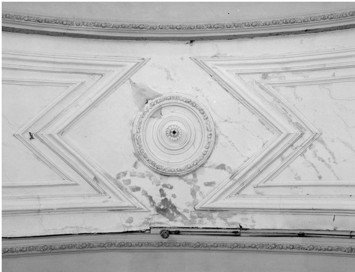
Détail des moulures en stuc, à l'entrée de l'abside.
