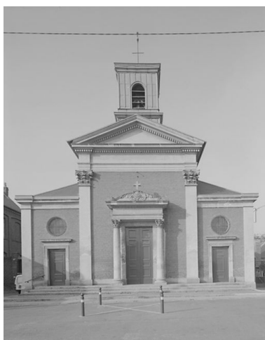
Vue générale. Phot. Thierry Lefébure IVR22_19968000242V
