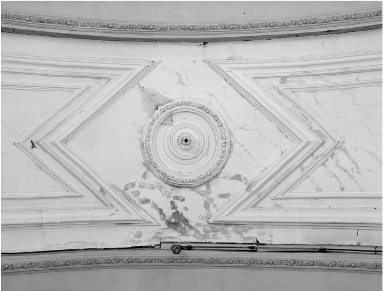
Détail des moulures en stuc, à l'entrée de l'abside.
