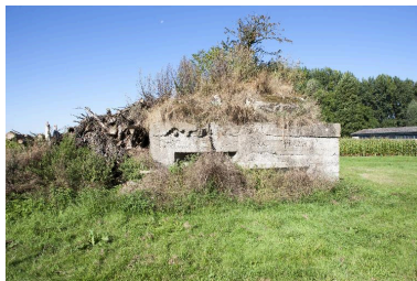
Vue vers l'ouest Phot. Pierre Thibaut IVR32_20165901326NUCA
