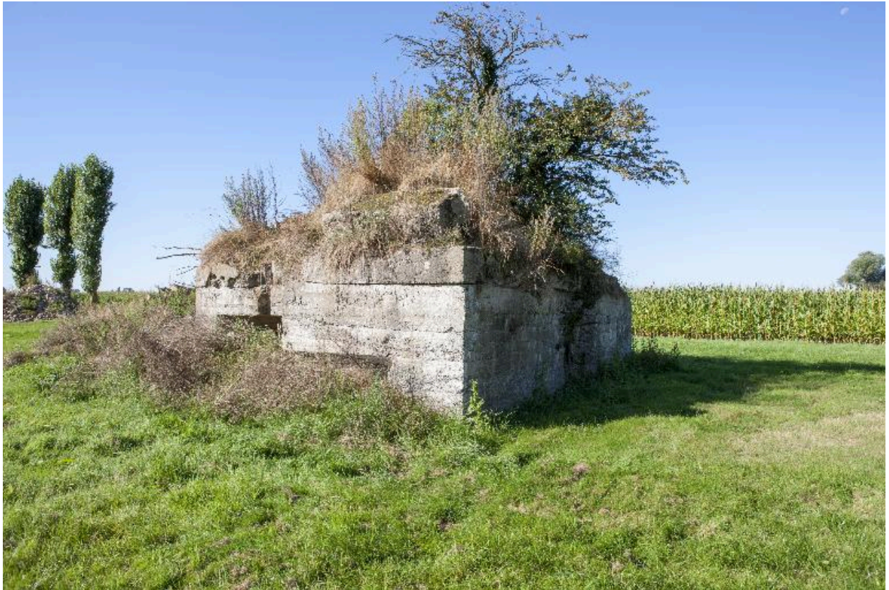
Vue vers le nord-ouest
