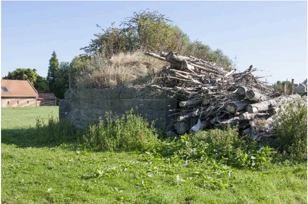
Vue vers le nord-est
