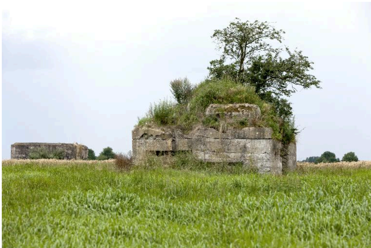
Vue générale vers le sud-ouest. A l'arrière plan le second poste d'artillerie (IA59004843)
