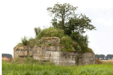
Vue générale, vers le sud-ouest Phot. Jean-Marc Ramette IVR31_20145904583NUCA
