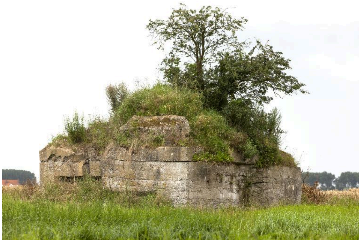
Vue générale, vers le sud-ouest
