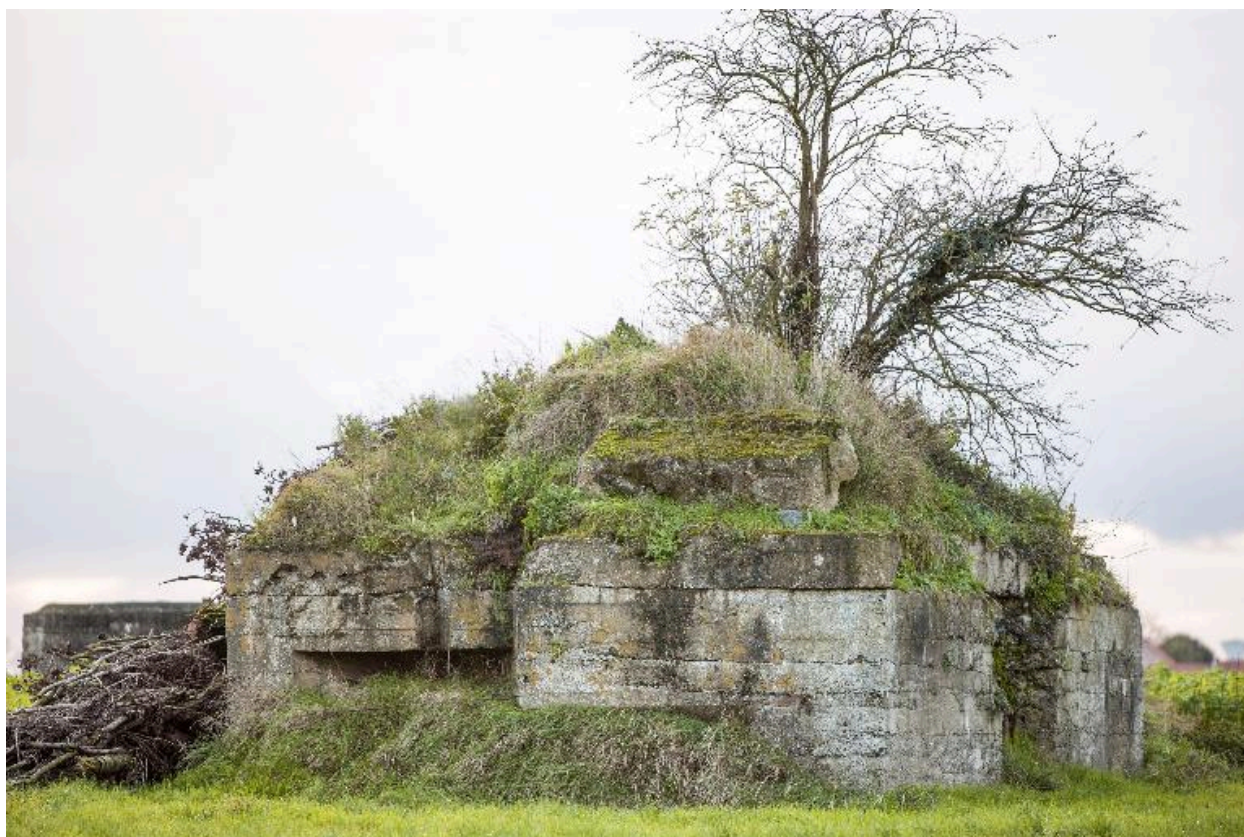
Vue générale, vers l'ouest
