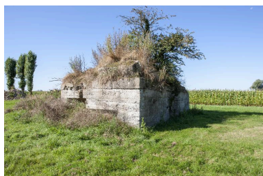
Vue vers le nord-ouest Phot. Pierre Thibaut IVR32_20165901325NUCA
