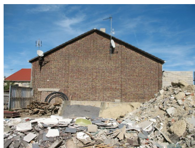
Mur pignon ouest de l'ancienne centrale. Phot. Clarisse Lorieux IVR22_20096005149NUCA
