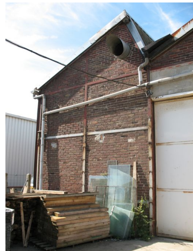
Détail d'une travée couverte en shed de l'ancien atelier des fûts d'emballage. Phot. Clarisse Lorieux IVR22_20096005148NUCA
