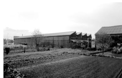
Atelier des fûts étanches en 1992. Phot. Benoît Dufournier IVR22_19926000213Z
