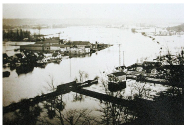
La tonnellerie sous les eaux de l'Oise lors de la crue de janvier 1926 (AC Nogent-sur-Oise ; fonds local). Phot. Clarisse Lorieux IVR22_20096005158NUCAB
