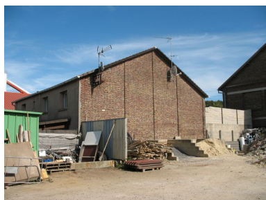
Ancienne centrale transformée en maison d'habitation. Phot. Clarisse Lorieux IVR22_20096005150NUCA
