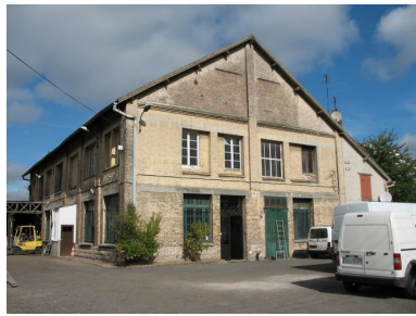
Vue générale de l'ancien atelier des fûts d'emballage et des bureaux. Phot. Clarisse Lorieux IVR22_20096005143NUCA
