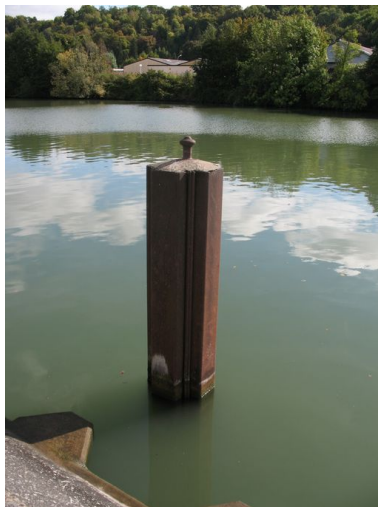
Bittes d'amarrage en fonte de l'ancien port de la tonnellerie. Phot. Clarisse Lorieux IVR22_20096005160NUCA
