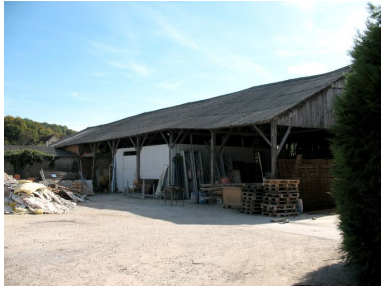
Hangar en bois construit pour le stock des fûts. Phot. Clarisse Lorieux IVR22_20096005155NUCA
