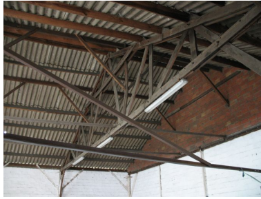
Détail de la charpente en bois du magasin de stock des fûts. Phot. Clarisse Lorieux IVR22_20096005156NUCA
