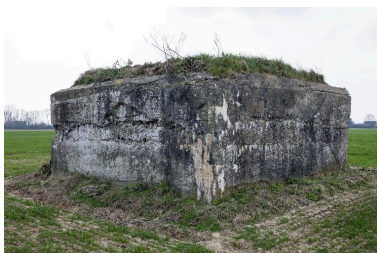
Vue vers de sud-ouest Phot. Pierre Thibaut IVR31_20155900606NUCA
