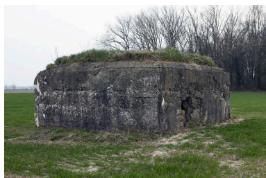
Vue générale vers le sud-est. Phot. Pierre Thibaut IVR31_20155900602NUCA
