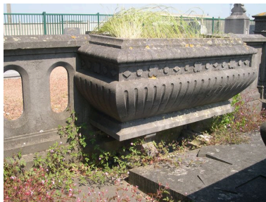
Vue de la clôture-jardinière. Phot. Isabelle Barbedor IVR22_20078010034NUCA
