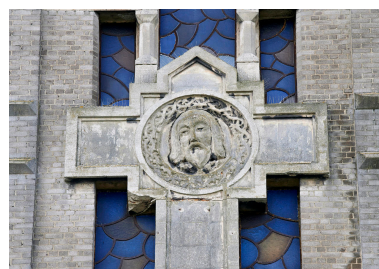
Détail de la croix en béton qui orne l'élévation nord du clocher : le visage du Christ.
