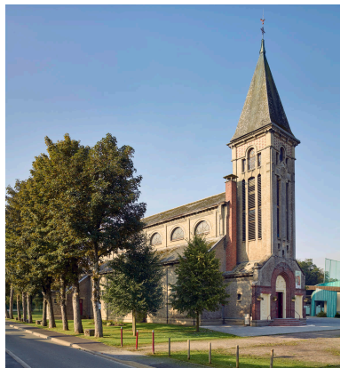
Élévation antérieure. Phot. Pierre Thibaut IVR32_20215900380NUCA
