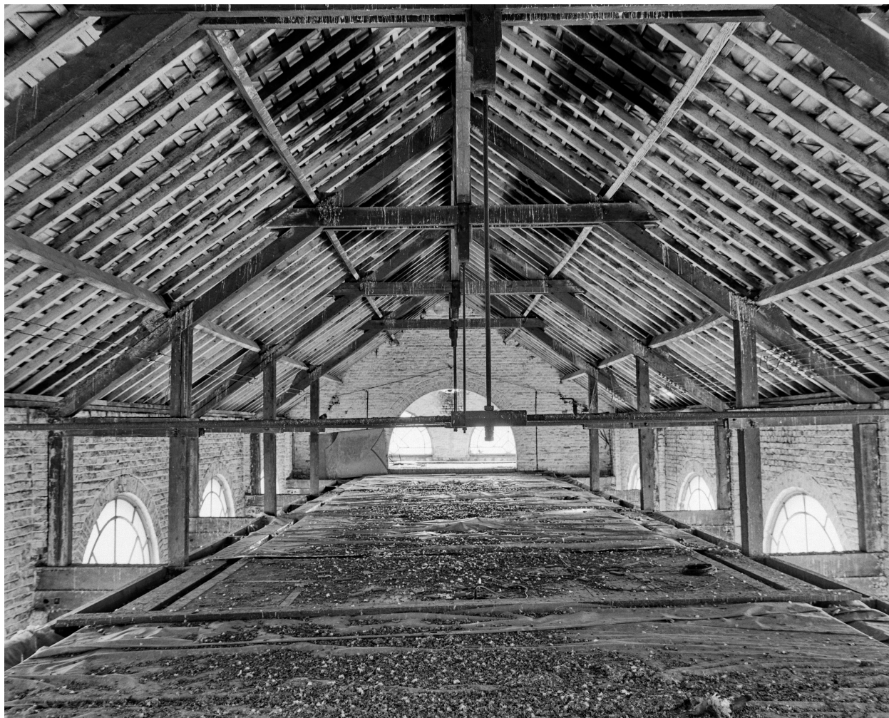
Vue générale des combles.
