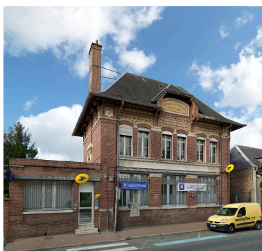
La poste de Flixecourt.
