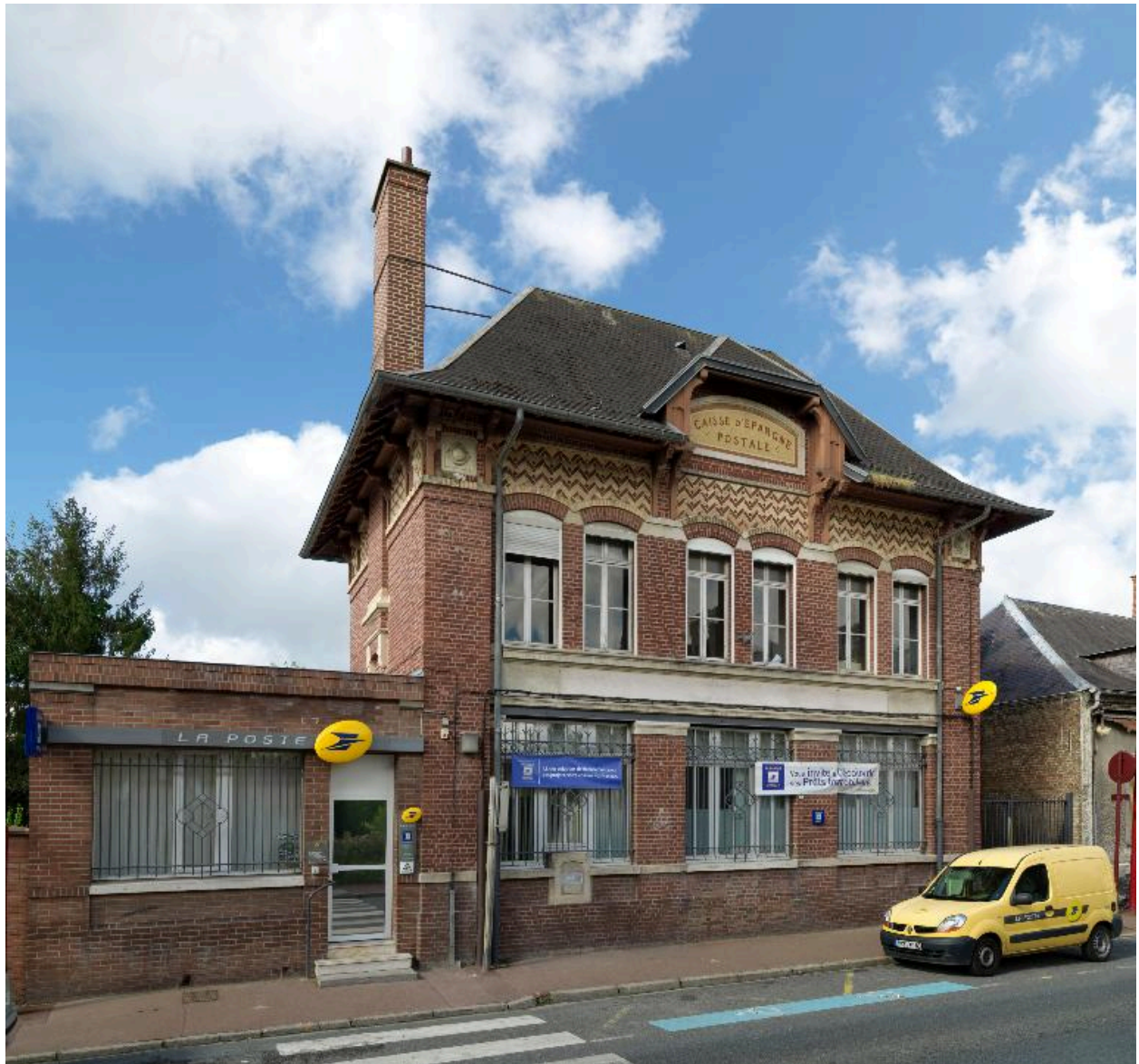
La poste de Flixecourt.
