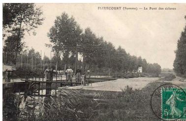
Le pont et les écluses sur la Somme à Flixecourt, vers 1910. (Coll. part.). Phot. Fournier Bertrand (reproduction) IVR22_20138016123NUCA
