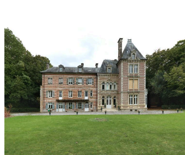
Le château Hesse. Phot. Thierry Lefébure IVR22_20128000835NUC2A
