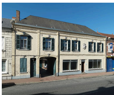
Immeuble sur rue (62, rue Roger-Godard). Phot. Thierry Lefébure IVR22_20128000611NUC2A
