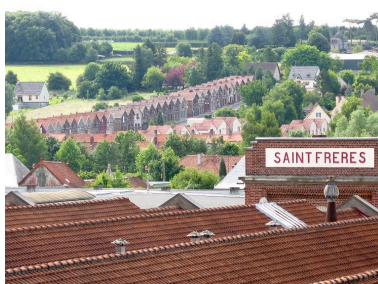
Toits de l'usine Saint Frères avec la cité Yves-Poiret à l'arrière plan. Phot. Bertrand Fournier IVR22_20138016050NUC2AQ
