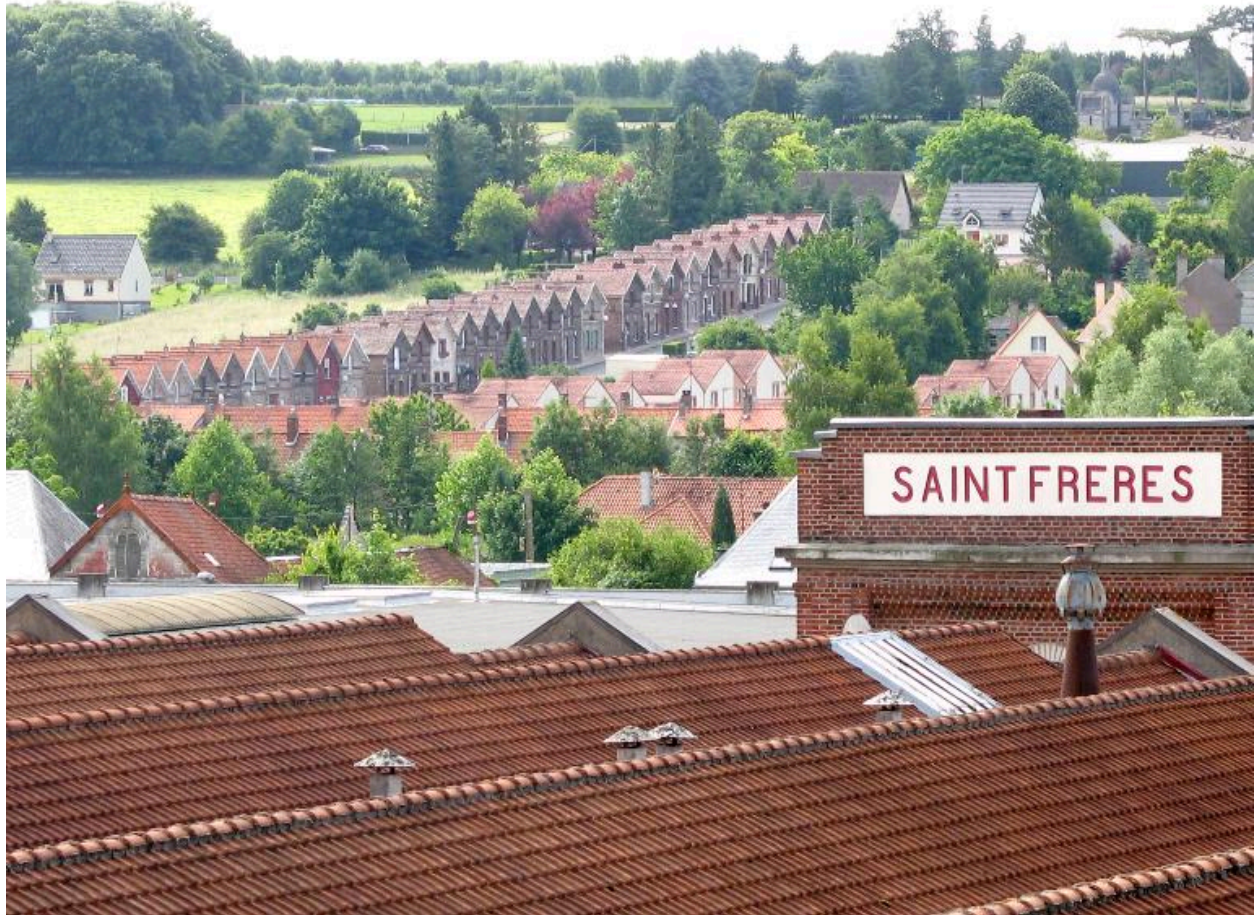
Toits de l'usine Saint Frères avec la cité Yves-Poiret à l'arrière plan.
