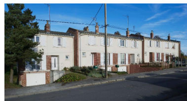
Immeuble du lotissement concerté, 1966-1968 (rue du 8 mai 1945). Phot. Thierry Lefébure IVR22_20138000544NUC2A
