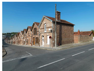
Cité ouvrière du Becquet ou Yves Poiret. Phot. Thierry Lefébure IVR22_20128000849NUC2A
