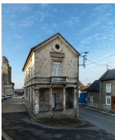
L'ancienne mairie. Phot. Thierry Lefébure IVR22_20138000516NUC2A
