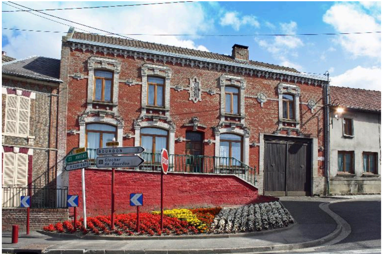
Maison avec entrée charretière à droite (1, esplanade de l'Eglise)
