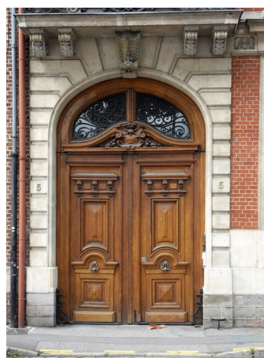
Vue de détail du portail. Phot. Isabelle Barbedor IVR22_20118010035NUCA
