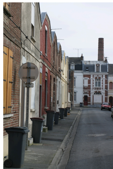
A gauche la cité Cartignies, au fond, la cheminée d'usine de l'ancien tissage Taine, Guillot et Cie. Phot. Frédéric Pillet IVR22_20060205100NUCA
