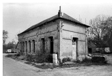
Conciergerie. Elévation antérieure. Phot. Thierry Lefébure IVR22_19888000592Z
