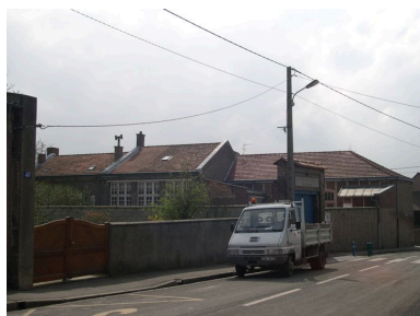
Vue de situation, depuis la rue Saint-Léger. Phot. Isabelle Barbedor IVR22_20058010261NUCA
